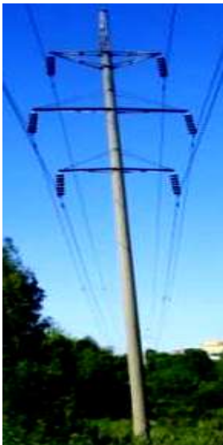
Фото 2. Визуально фиксируемый крен опоры № 30.
