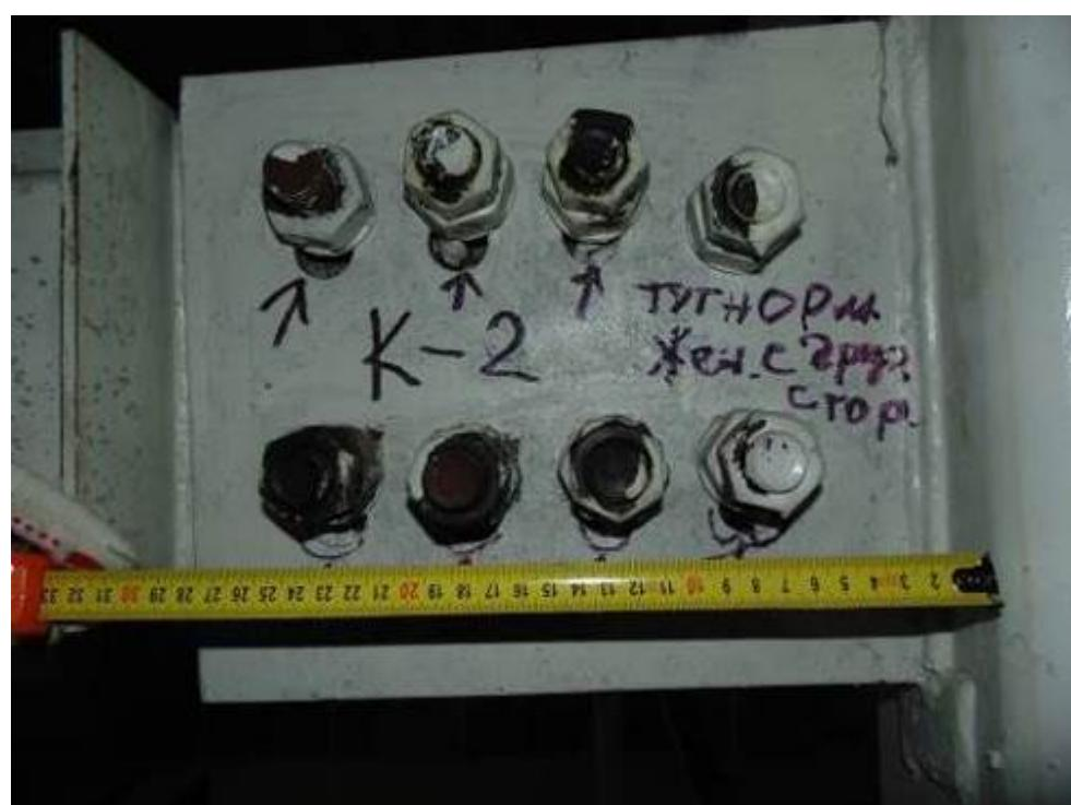
Фото 155. Узел соединения фермы с колонной на участке в осях Д-Ж между осей 2-4.
