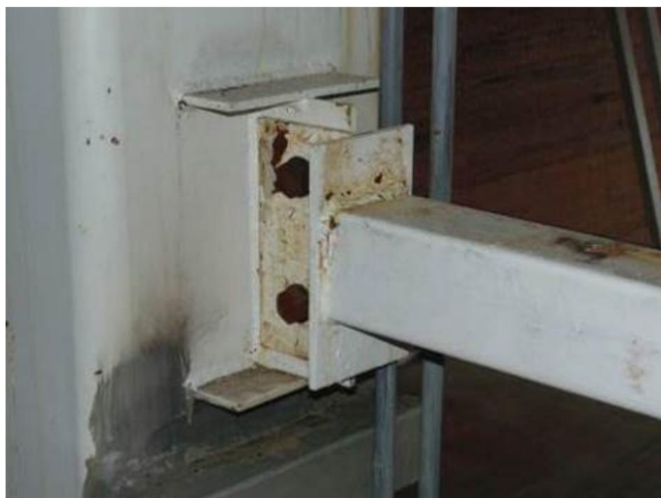
Фото 165. Узел крепления продольных прогонов на участке в осях Г-Е между осей 2-4.
