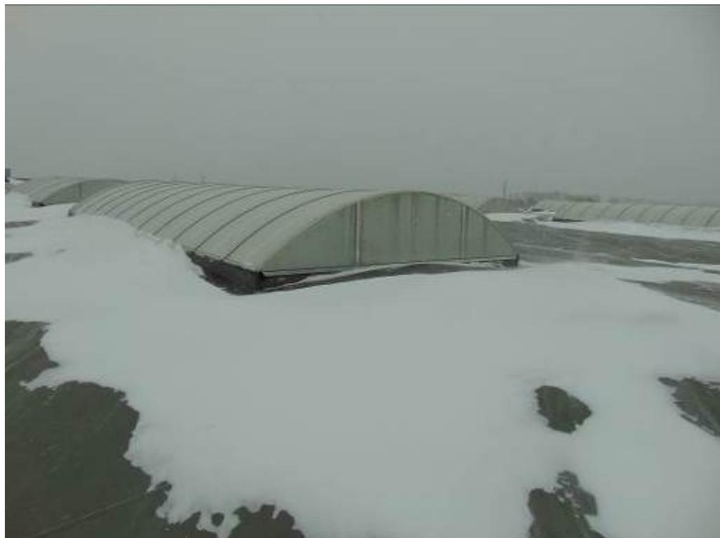
Фото 17. Фрагмент кровли. Зенитный фонарь.
