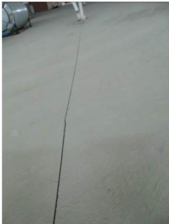
Фото 240. Технологический шов в бетонной подготовке пола по оси Е.
