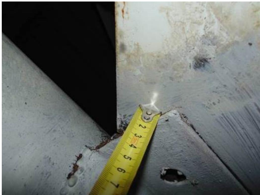
Фото 160. Узел крепления связей к колоннам на уровне ферм на участке в осях Г-Е между осей 2-4.
