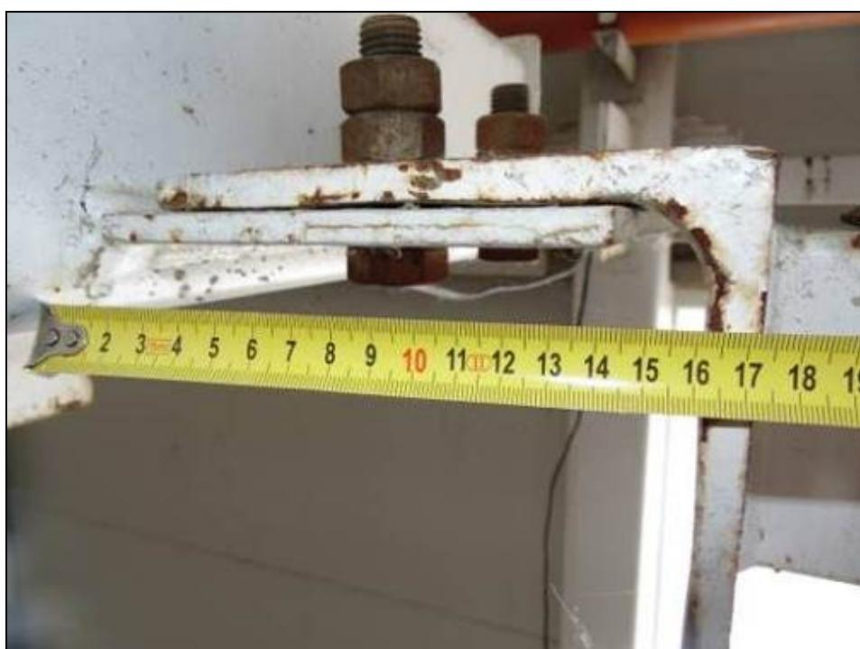
Фото 121. Узел соединения фермы со связью на участке в осях Ц-Э между осей 1-3. Уголок не плотно прилегает к косынке в следствии не достаточной затяжки гаек болтового соединения. Видны повреждения окрасочного покрытия и следы коррозии. Болты и гайки не обработаны антакоррозийным составом.
