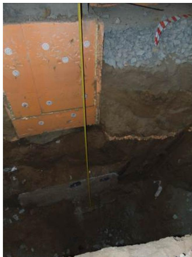
Фото 26. Шурф 4. Общий вид монолитного ростверка. Выполнена теплоизоляция из экстрадированного пенополистерола.
