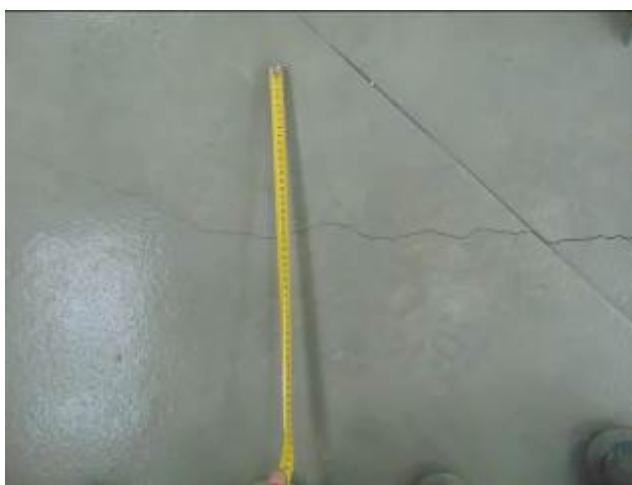
Фото 256. Трещина в конструкции фибробетонной плиты.
