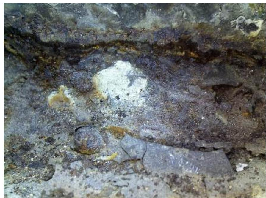
Фото 8. Узел соединения фермы с колонной на участке в осях Д-Ж между осей 2-4. Сварной шов имеет отслоения и нагары. Структура шва пористая.
