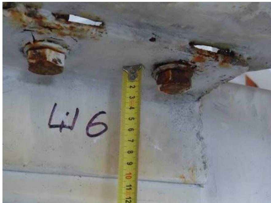
Фото 136. Узел крепления связей на участке в осях П-О между осей 2-4. Узел выполнен не по проекту. Предпринята попытка усилить болтовое соединение дополнительным сварным швом. Качество сварных швов низкое. Видны следы коррозии. Болты, гайки и шайбы не обработаны антакоррозийным составом.
