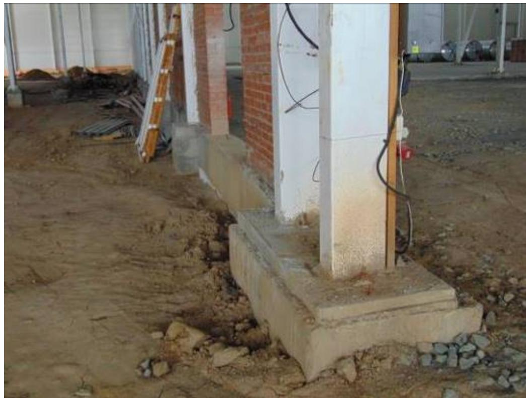
Фото 96. Опирание колонн на фундамент на участке температурного шва.
