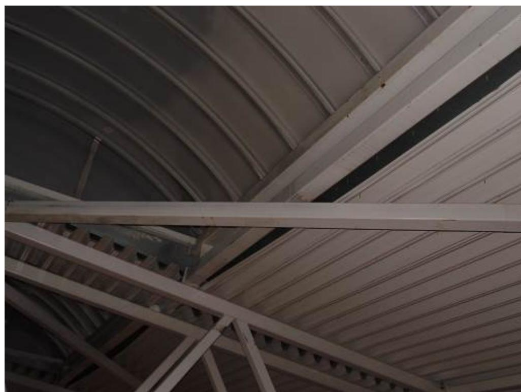
Фото 266. Смещение (прогиб) профилированного листа в конструкции кровли.
