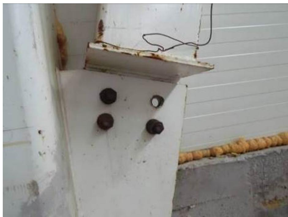
Фото 143. Узел крепления связи к колонне на участке в осях К-М между осей 1-3.
