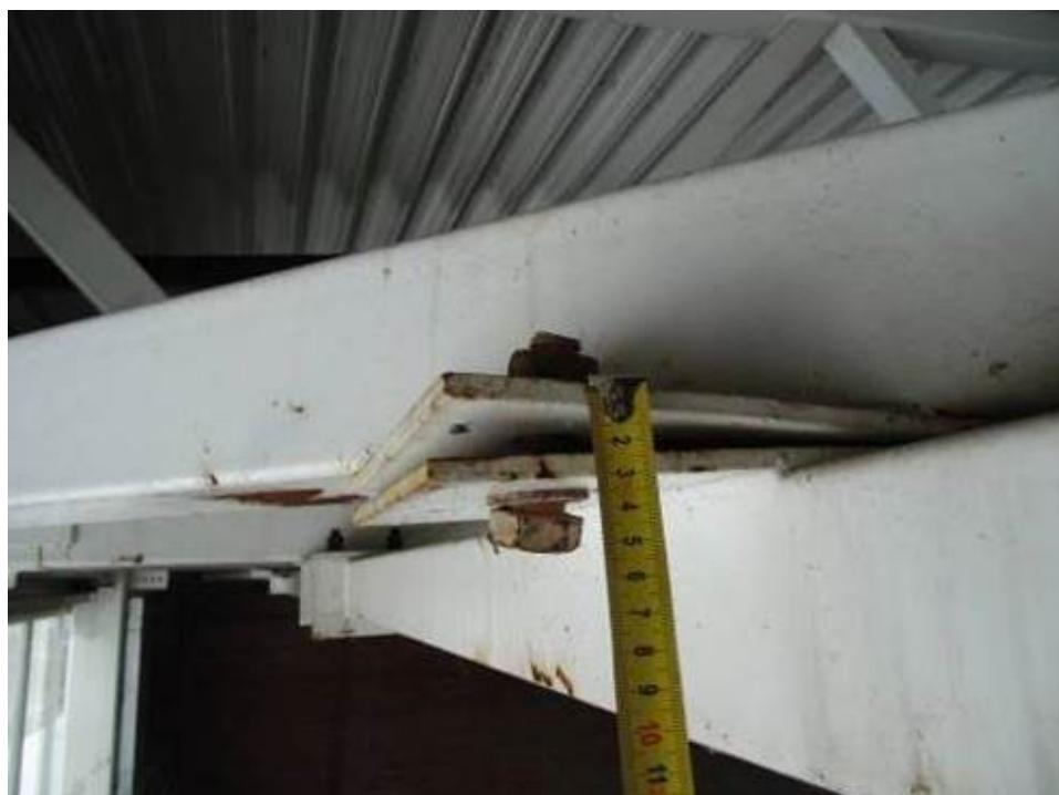
Фото 127. Узел крепления связи к ферме на участке в осях Ц-Э между осей 1-3. В следствии не достаточной затяжки гайки болтового соединения образовался зазор между монтажными деталями стыкуемых элементов. Повреждено окрасочное покрытие металлических конструкций. Видны следы коррозии.
