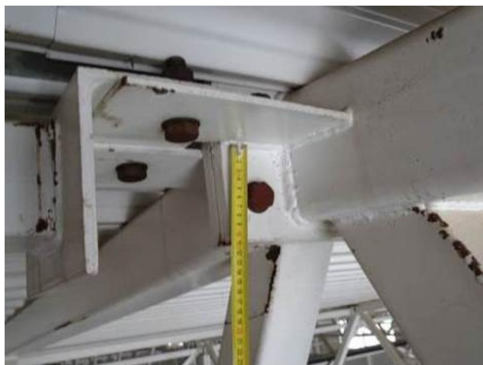
Фото 113. Узел соединения сборочных сегментов фермы и крепления связи на участке в осях Ц-Э между осей 6-7.
