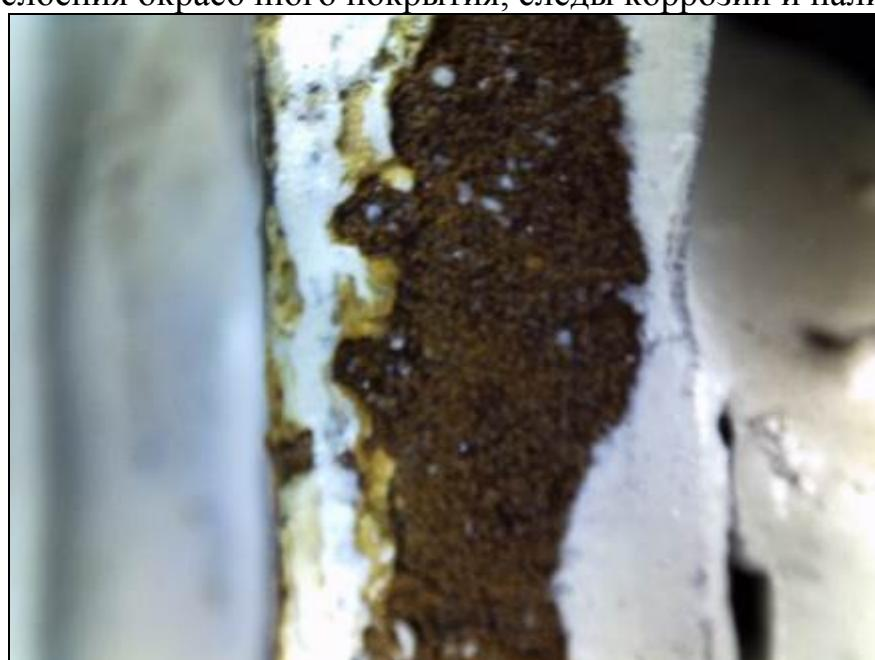
Фото 7. Узел крепления связей на участке в осях П-О между осей 2-4. Выявлено разрушение окрасочного покрытия и следы интенсивной коррозии.
