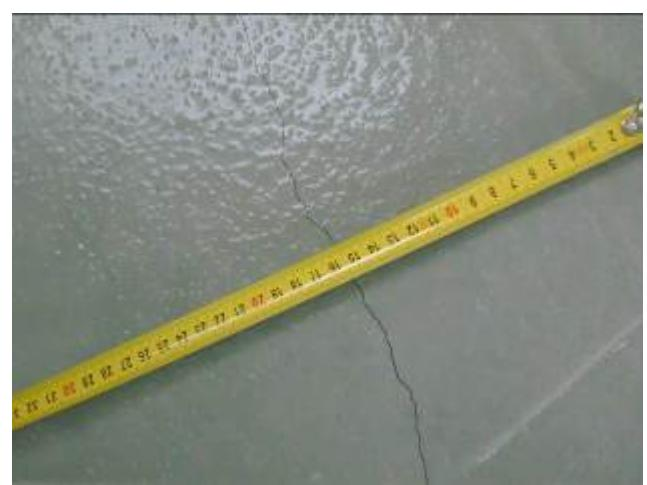
Фото 257. Трещина в конструкции фибробетонной плиты.
