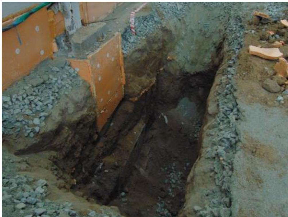
Фото 27. Шурф 4. Общий вид монолитного ростверка. Выполнена теплоизоляция из экстрадированного пенополистерола.
