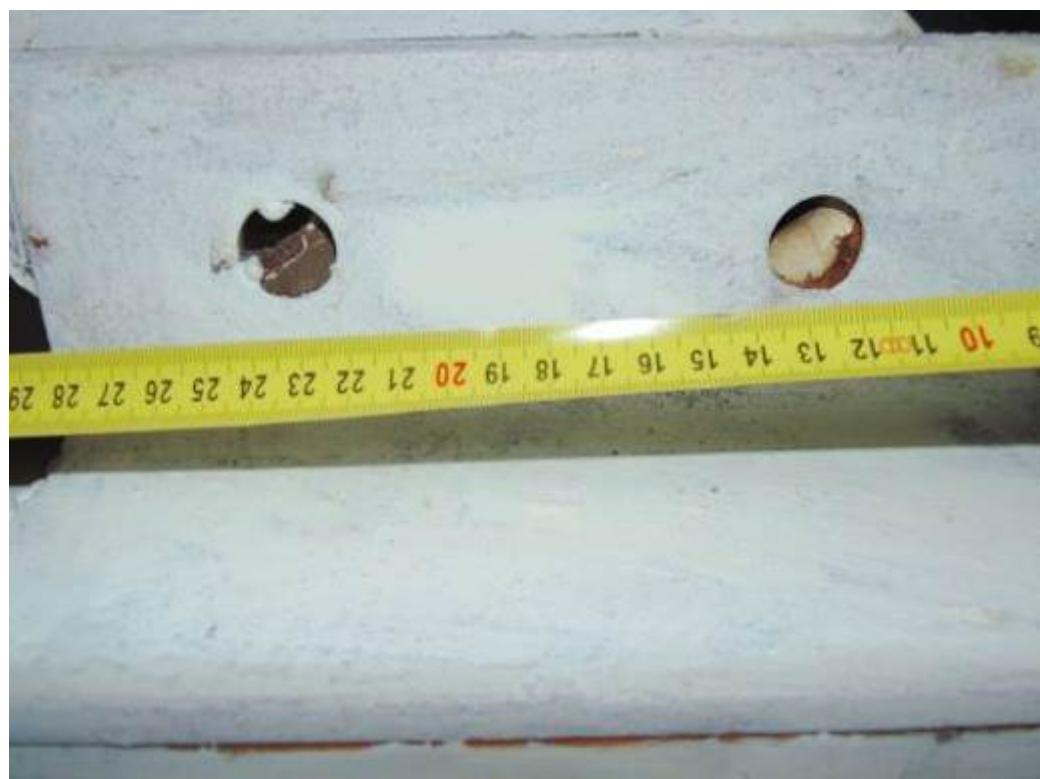
Фото 159. Узел крепления связей к колоннам на уровне ферм на участке в осях Г-Е между осей 24.
