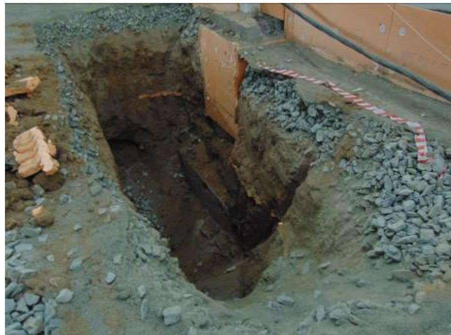
Фото 25. Шурф 4. Общий вид монолитного ростверка. Выполнена теплоизоляция из экстрадированного пенополистерола.
