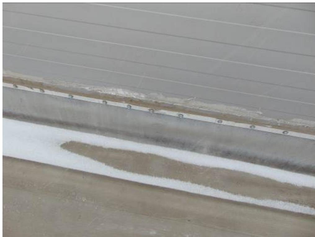
Фото 264. Неаккуратное примыкание мембраны к вертикальным конструкциям.
