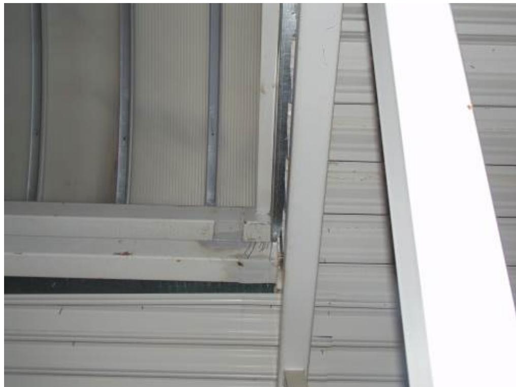
Фото 265. Смещение профилированного листа в конструкции кровли.
