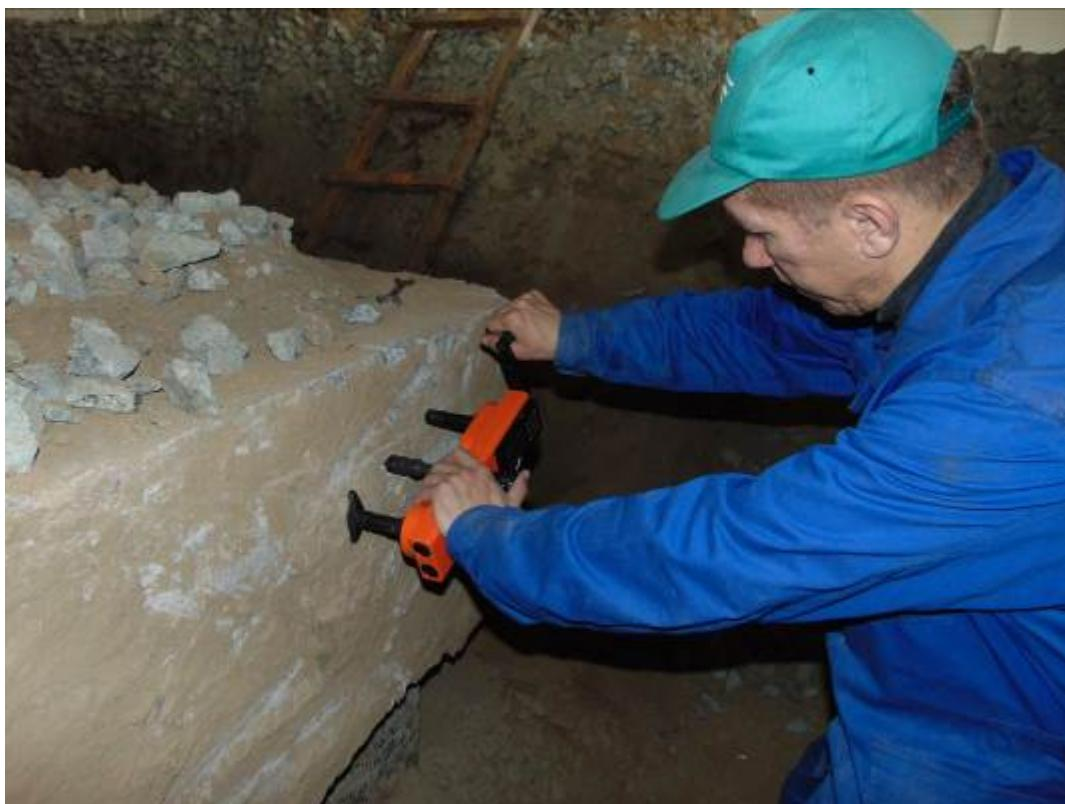
Фото 20. Шурф 1. Производится определение прочности бетона ростверков методом отрыва со скальванием.
