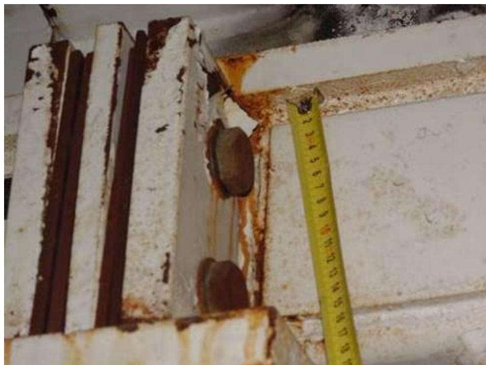
Фото 157. Узел опирания фермы на колонну на участке в осях Г-Е между осей 2-4.
