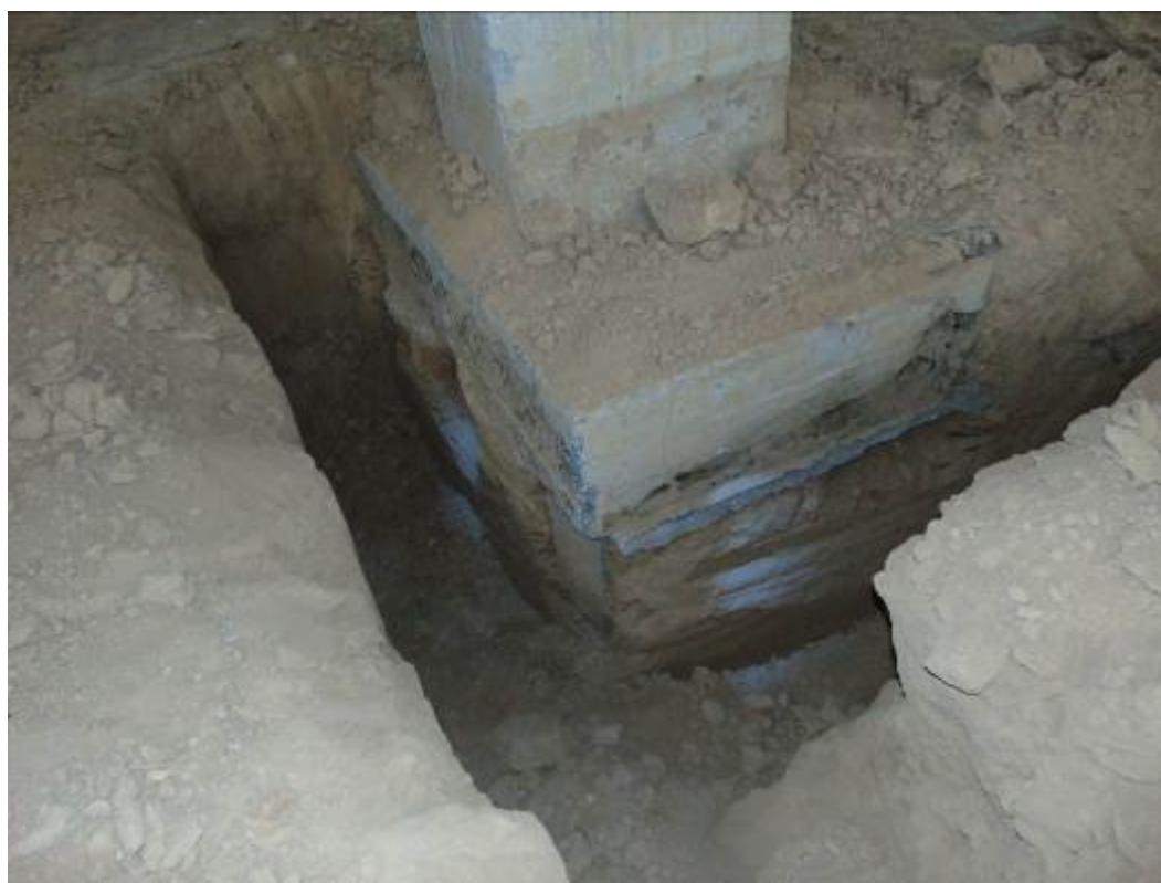
Фото 30. Шурф 6. Монолитный железобетонный ростверк. Под ростверком видны забивные железобетонные сваи.
