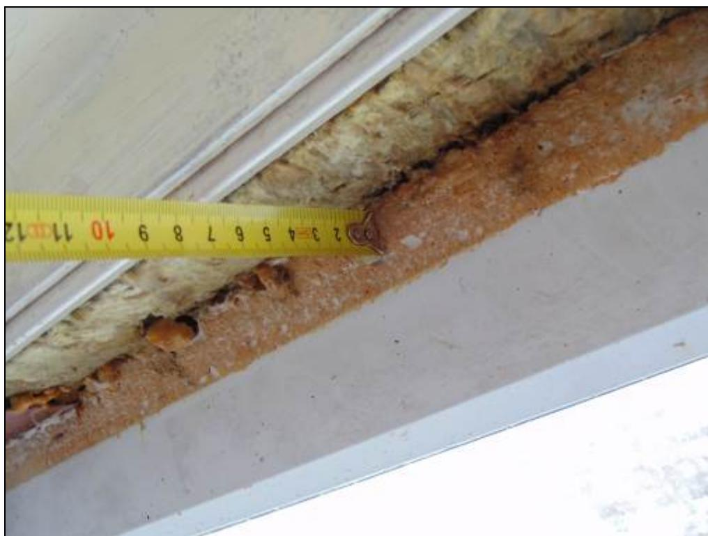
Фото 272. Примыкание оконного блока к стене не выполнено. Откосы не оформлены.
