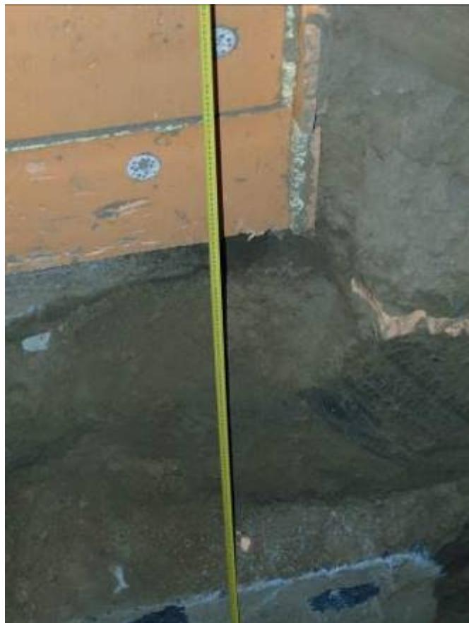
Фото 39. Выполнена теплоизоляция из экстрадированного пенополистерола цокольных стен по периметру здания.
