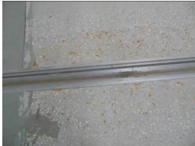
Фото 258. Коррозия фибры на поверхности фибробетонного основания пола вследствии повреждения защитного слоя.
