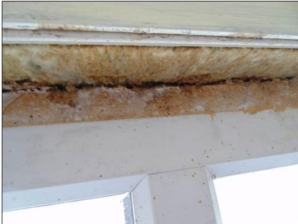
Фото 271. Примыкание оконного блока к стене не выполнено. Откосы не оформлены.
