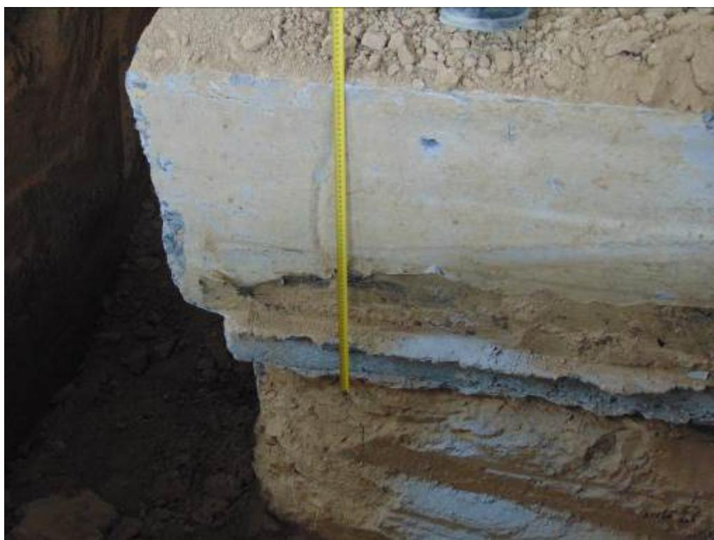
Фото 28. Шурф 5. Монолитный железобетонный ростверк.
