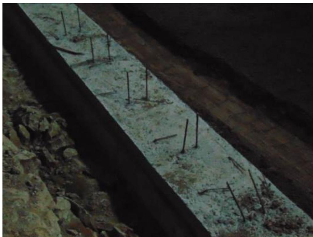
Фото 54. Фрагмент фундамента в помещение в осях 01-1/А-Ю. Видны арматурные выпуски под железобетонные монолитные подпорные стены.
