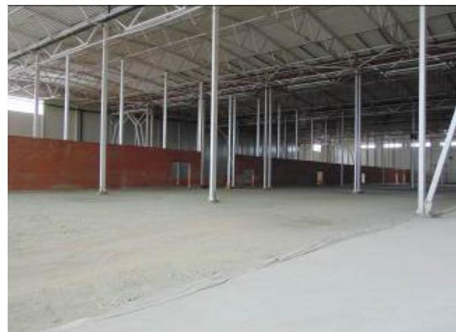
Фото 243. Бетонная подготовка по оси Е.
