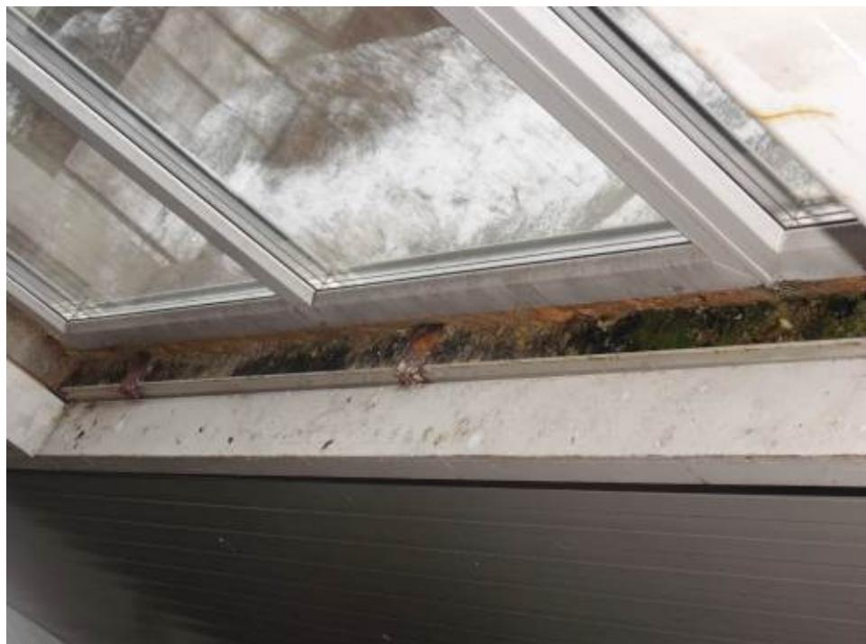
Фото 274. В следствии того что, откосы по оконным проемам небыли выполнены, от увлажнения на утеплителе выявлены признаки биогенного поражения (мох).
