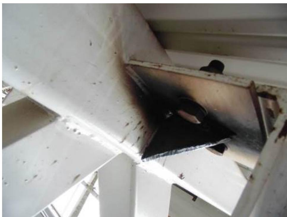
Фото 117. Узел крепления связи к верхнему поясу фермы на участке в осях Ц-Э между осей 6-7 выполнен с нарушением требований проектной документации. Элементы узла имеют неопределенные геометрические характеристики. Сварка выполнена грубо, сварной шов не однороден. Повреждено окрасочное покрытие.
