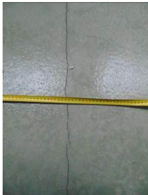
Фото 250 - 251. Трешины в конструкции фибробетонного пола.
