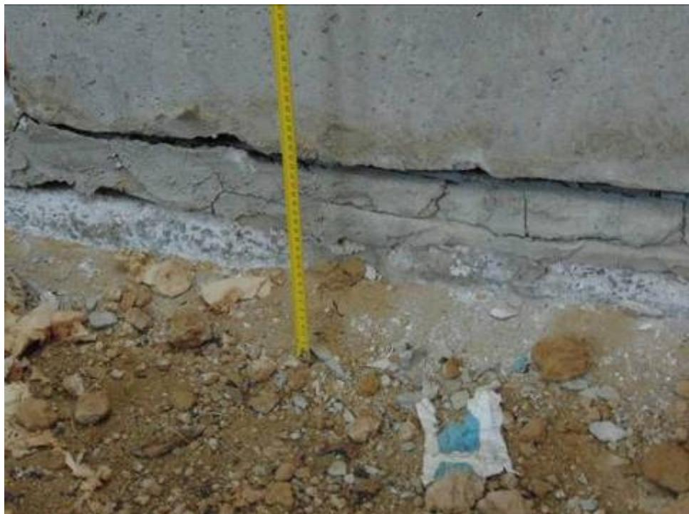
Фото 51. Фрагмент основания кирпичной стены вдоль осей В-Г, между осями 7-8. Основание выполнено из сборных бетонных стеновых фундаментных блоков. Видны трещины по швам укладки блоков шириной до 30мм возникшие в следствии просадок грунта-основания. Значительно превышена толщина горизонтального шва (толщина шва до 100мм).
