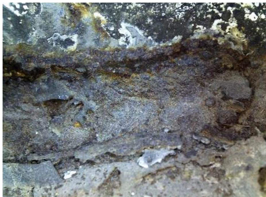
Фото 10. Элемент опирания инженерных сетей выполнен не по проекту на участке в осях Г-Е между осей 2-4. Сварной шов имеет отслоения и нагары. Структура шва пористая.
