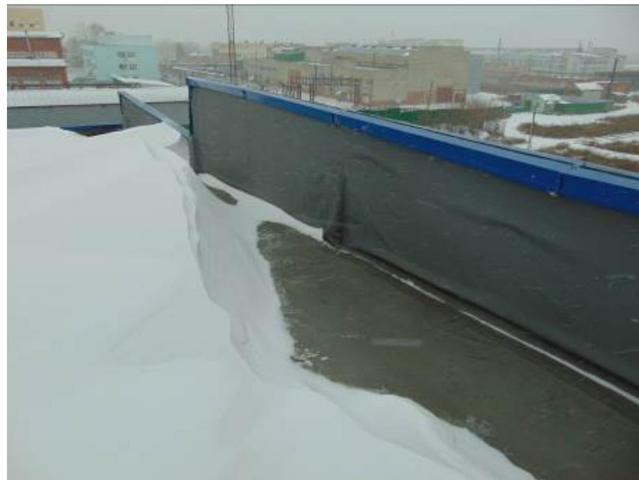
Фото 261. Складки мембранны на вертикальной стене парапета.
