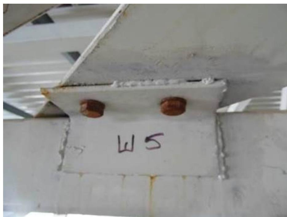
Фото 141. Узел крепления связей на участке в осях П-О между осей 2-4. Узел выполнен не по проекту. Предпринята попытка усилить болтовое соединение дополнительным сварным швом. Качество сварных швов низкое. Деталь опириания (уголок) подготовлен «кустарно». Видны следы коррозии. Болты, гайки и шайбы не обработаны антикоррозийным составом.
