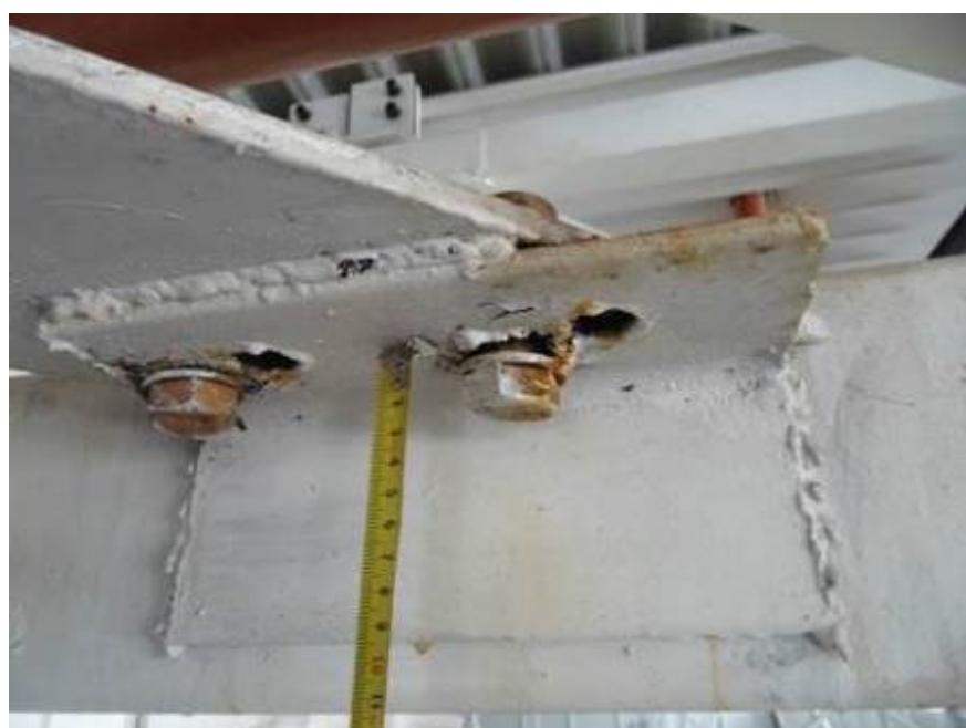
Фото 137. Узел крепления связей на участке в осях П-О между осей 2-4. Узел выполнен не по проекту. Болтовое соединение усилено сварным швом. В виду смещения детали из уголка при установке произошло смещение монтажных отверстий болтовых соединений. Отверстия в детали получены не сверлением, прожжены сваркой. Видны следы коррозии. Бетовые соединения не натянуты.
