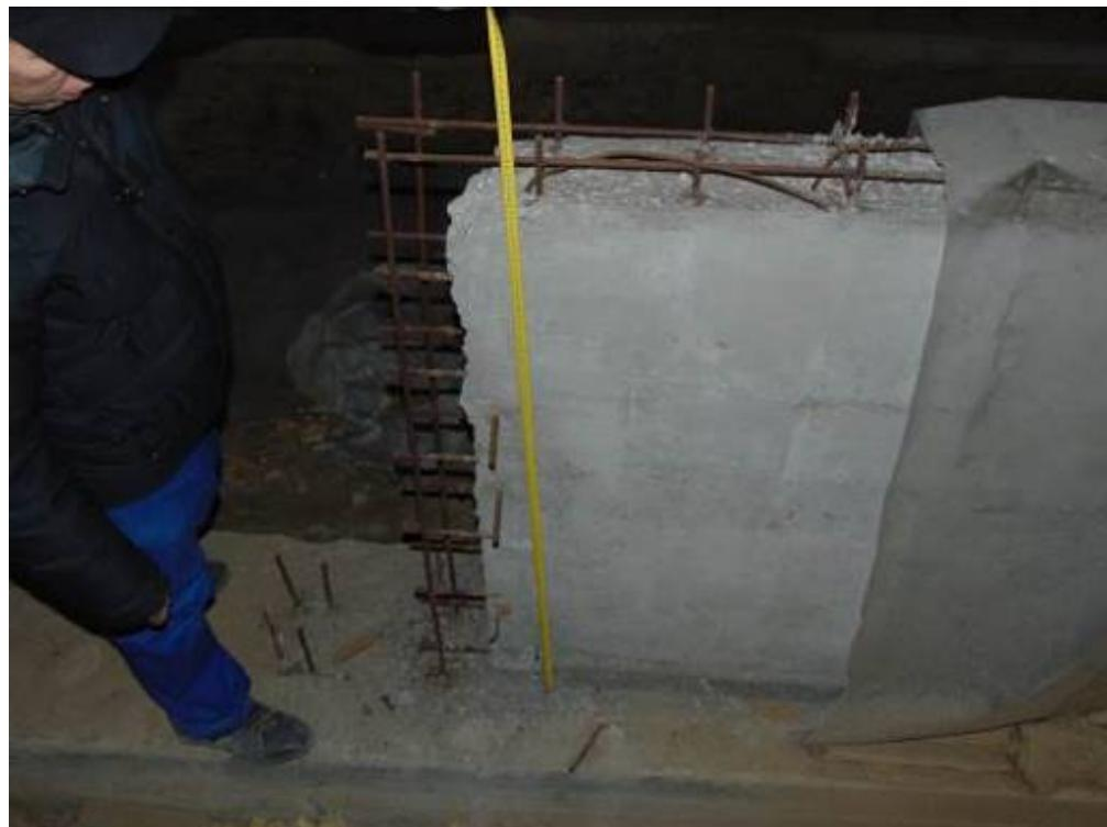
Фото 59. Участок подпорной стены в осях 01-1/А-Ю. Подпорные стены в помещении в осях 01-1/А-Ю выполнены не в полном объеме. Виден арматурный каркас. Высота возведенного участка 1,6м.
