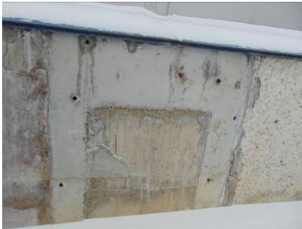
Фото 67. Видны участки промерзания, а также раковины на поверхности бетона цокольной стены. Вид со стороны улицы.
