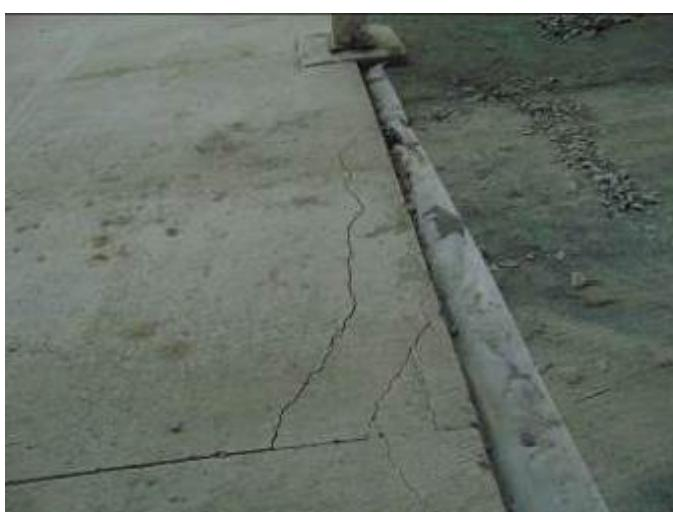
Фото 227. Разрушение бетонной подготовки под полы.
