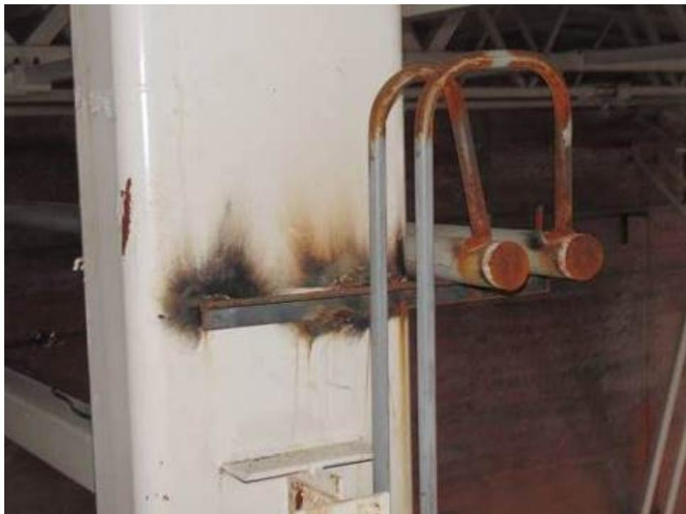
Фото 166. Элемент опирания инженерных сетей выполнен не по проекту на участке в осях Г-Е между осей 2-4.
