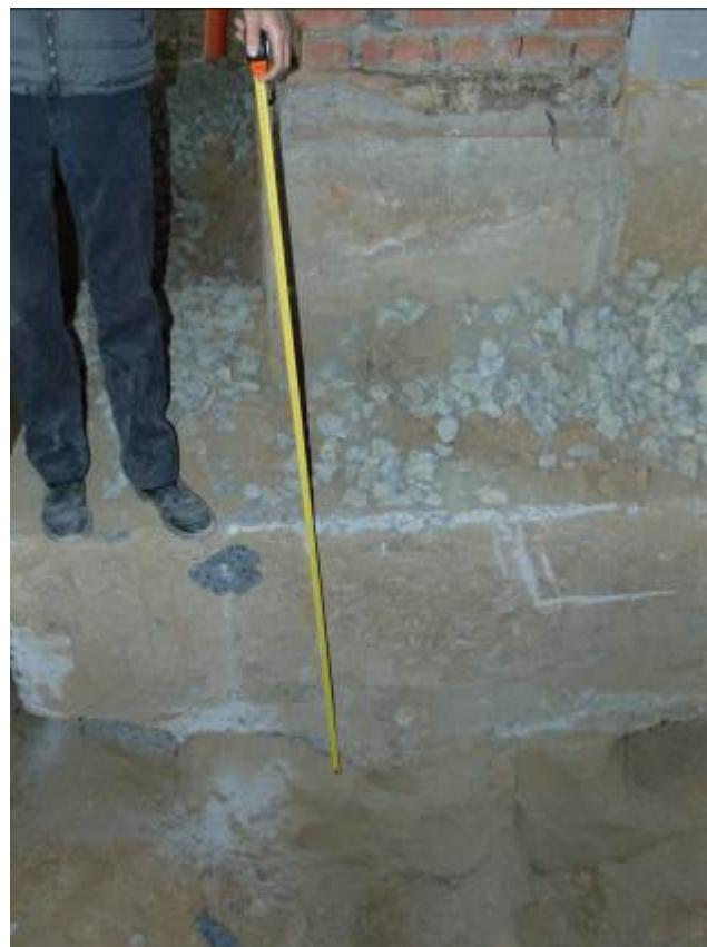
Фото 24. Шурф 3. Железобетонный монолитный ростверк.
