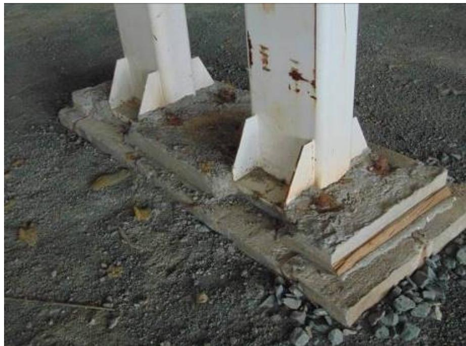
Фото 94. Узел опирания колонны на фундамент на участке температурного шва. Отсутствует антикоррозийное покрытие анкеров, шайб и гаек. Окрасочное (антикоррозийное) покрытие колонны повреждено, видны следы коррозии на колонне.
