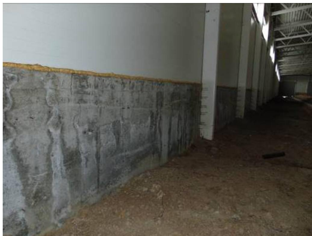
Фото 60. Видны протечки на поверхности железобетонной монолитной цокольной стены по оси 01 в осях Т-У.
