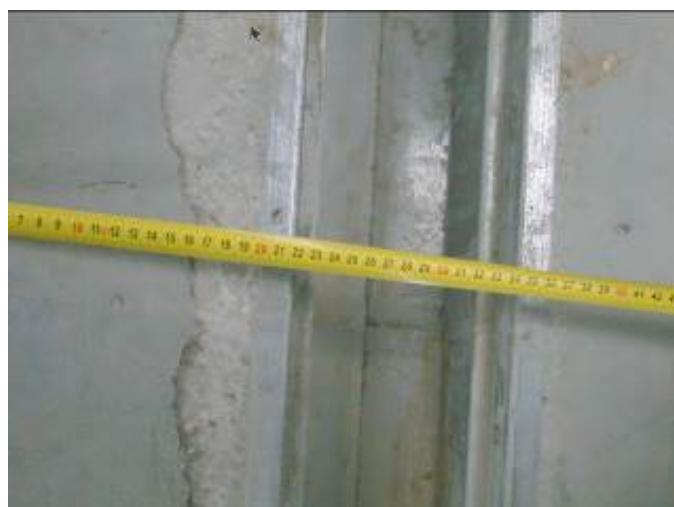
Фото 259. Разрушение верхнего слоя в покрытии наливного пола у края кромки технологического желоба.
