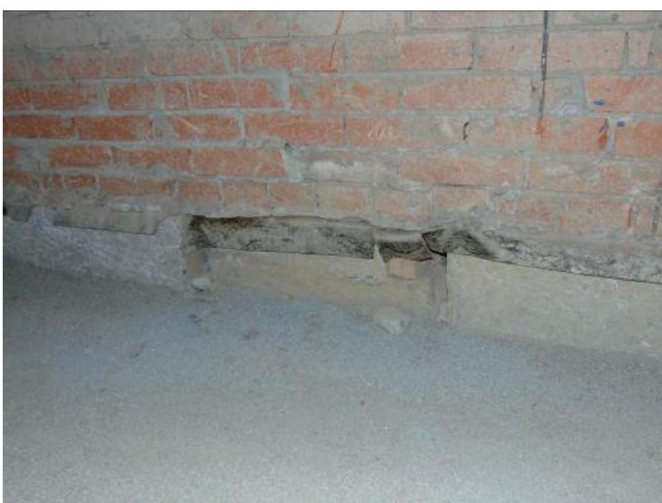
Фото 52. Выполнена горизонтальная гидроизоляция из рулонного гидроизоляционного материала (гидростеклоизол).
