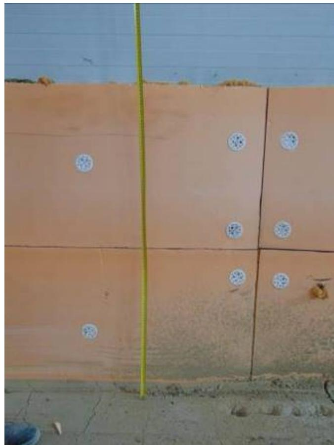
Фото 45. Цокольная стена утеплена экстрадированным пенополистеролом.
