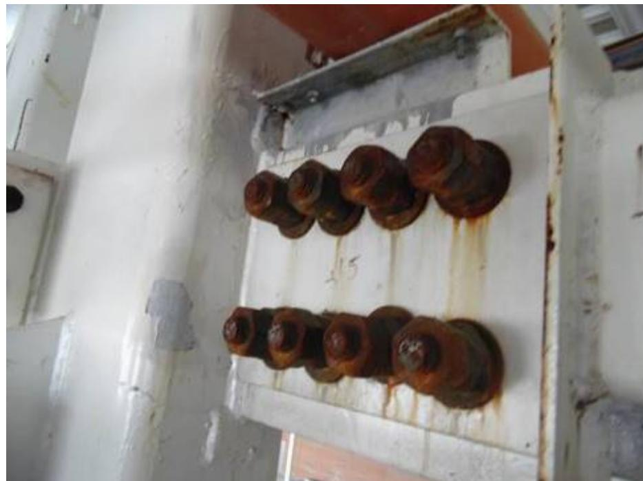
Фото 140. Узел крепления фермы к колонне на участке в осях П-О между осей 2-4.
