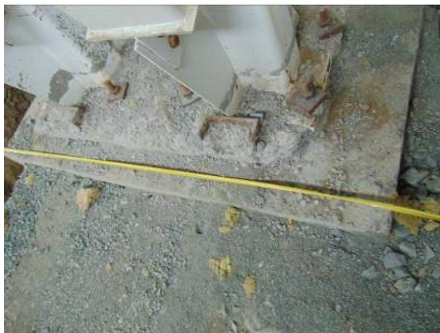
Фото 77. Узел опирания колонны на фундамент на участке температурного шва.
