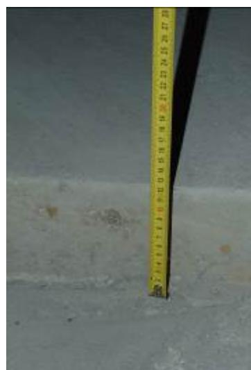
Фото 228, 229. Толщина бетонной подготовки под полы 110-130мм.
