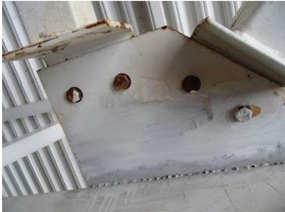
Фото 110. Узел соединения связей с фермой на участке в осях Ц-Э между осей 6-7. Окрасочное покрытие металлоконструкций повреждено, видны следы коррозии. Болты не обработаны анткоррозийным покрытием и поражены коррозией. Сварной шов соединения косынки с поясом фермы не однороден по лине и толщине.
