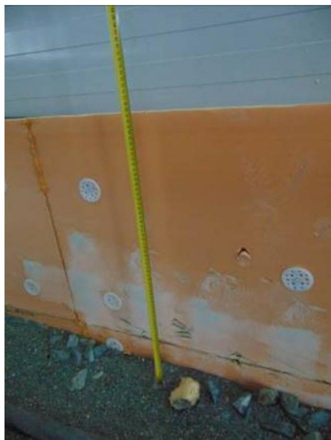
Фото 36. Выполнена теплоизоляция из экстрадированного пенополистерола цокольных стен вдоль наружных стен.
