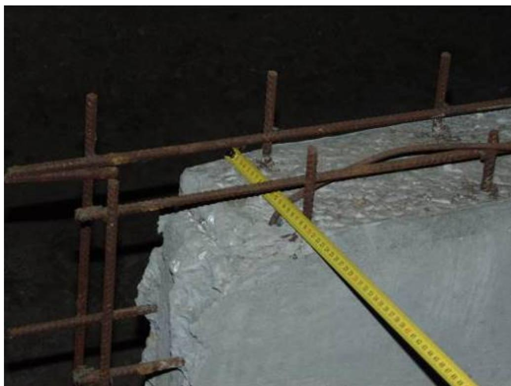
Фото 58. Участок подпорной стены в осях 01-1/А-Ю. Подпорные стены в помещении в осях 01-1/А-Ю выполнены не в полном объеме. Виден арматурный каркас. Толщина стен 200мм.
