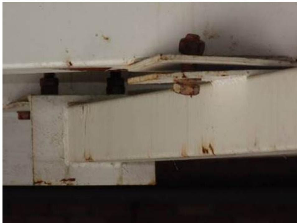
Фото 126. Узел крепления связи к ферме на участке в осях Ц-Э между осей 1-3. В следствии не достаточной затяжки гайки болтового соединения образовался зазор между монтажными деталями стыкуемых элементов.
