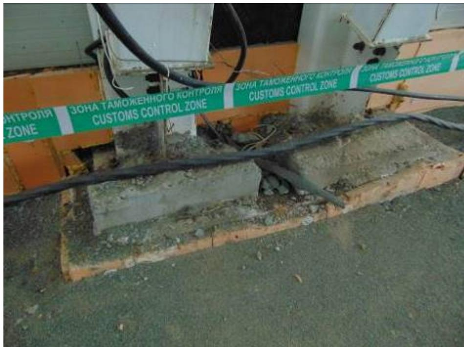
Фото 35. Выполнена теплоизоляция из экстрадированного пенополистерола железобетонных ростверков и цокольных стен вдоль наружных стен.
