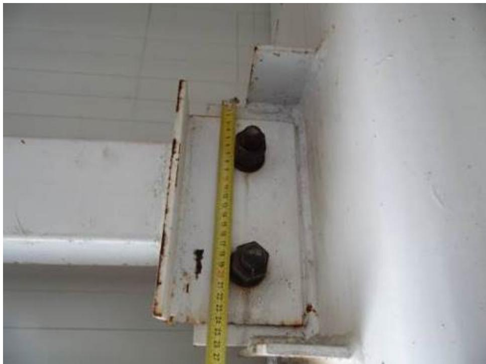
Фото 128. Окрасочное покрытие повреждено на участке в осях Ц-Э между осей 1-3. Видны следы коррозии.
