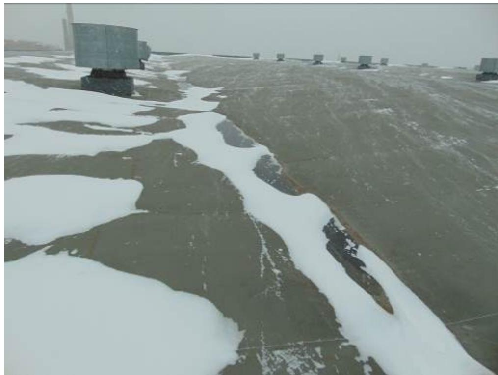
Фото 262. Застой воды на участке поверхности кровли в складке мембранны.
