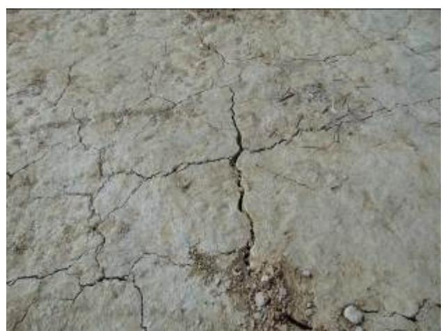
Фото 247- 248. Просадка и растрескивание грунтового основания в осях 1-8/В-Г.
