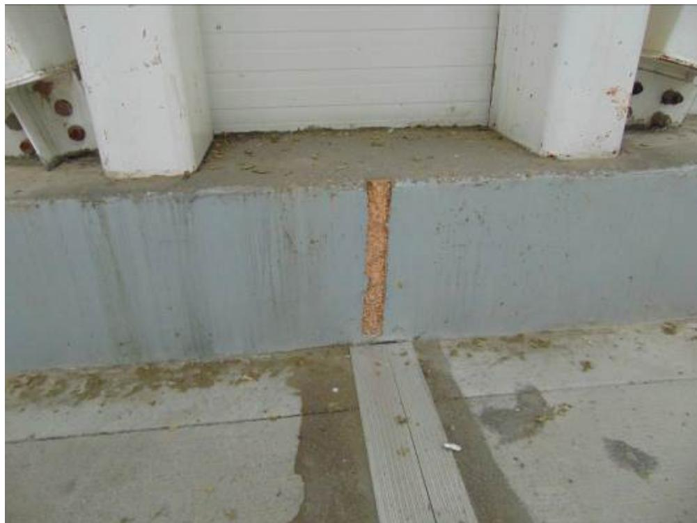
Фото 53. Заполнение температурного шва на участке цокольной стены в осях П/8 выполнено монтажной пеной, что является нарушением требований проектной документации.
