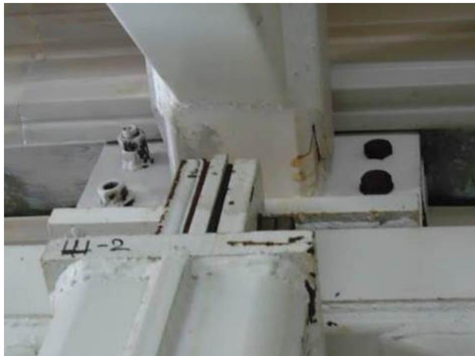
Фото 144. Узел опирания фермы на колонну на участке в осях К-М между осей 1-3.
