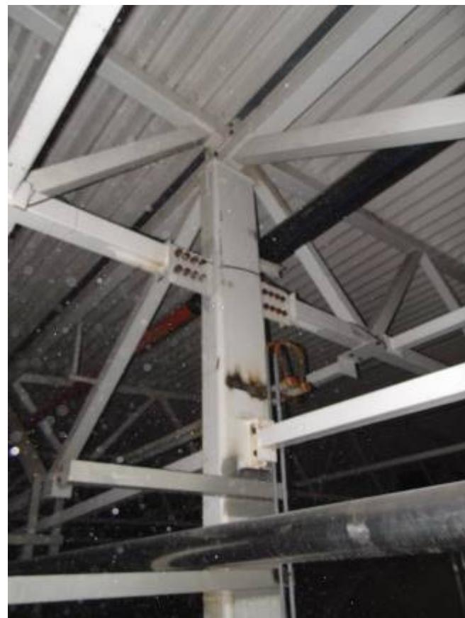
Фото 101. Верхний оголовок колонны. Узел опирания и крепления ферм к колонне.
