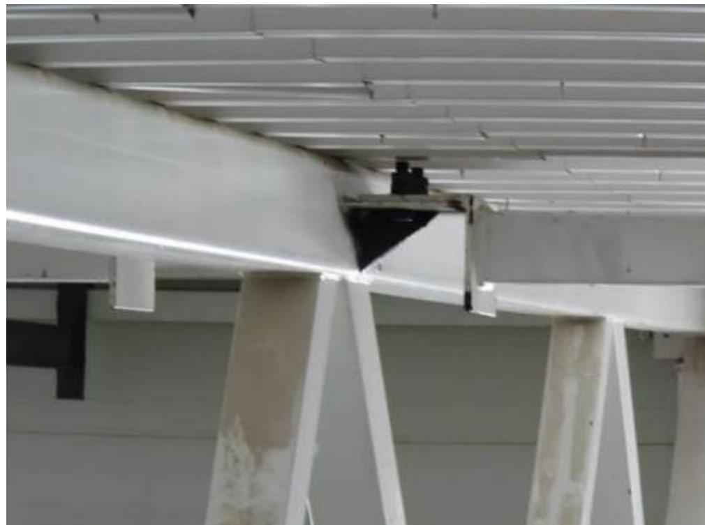
Фото 116. Узел крепления связи к верхнему поясу фермы на участке в осях Ц-Э между осей 6-7.
