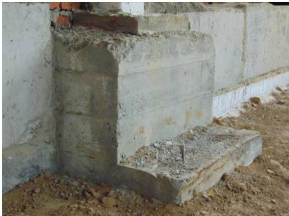
Фото 43. Подколонная часть железобетонного монолитного фундамента под колонну фахверка вдоль осей Г-В между осями 6-7.
