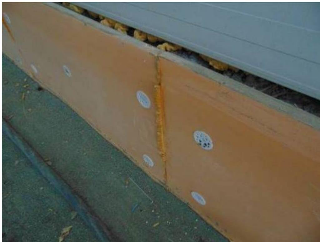
Фото 37. Выполнена теплоизоляция из экстрадированного пенополистерола цокольных стен вдоль наружных стен.
