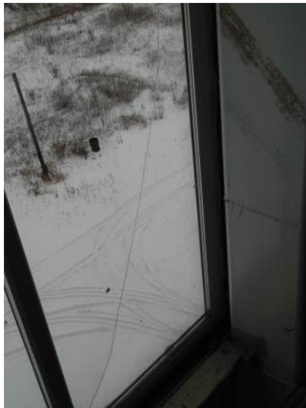
Фото 273. Трещина в стеклопакете.
