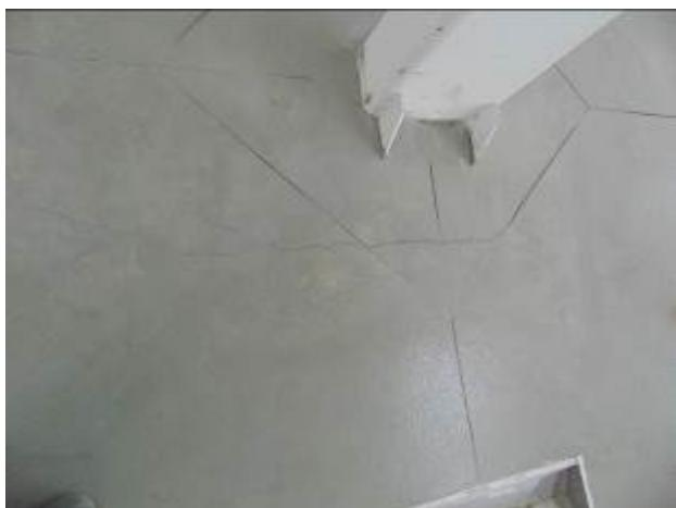
Фото 254. Трещина в конструкции фибробетонной плиты.
