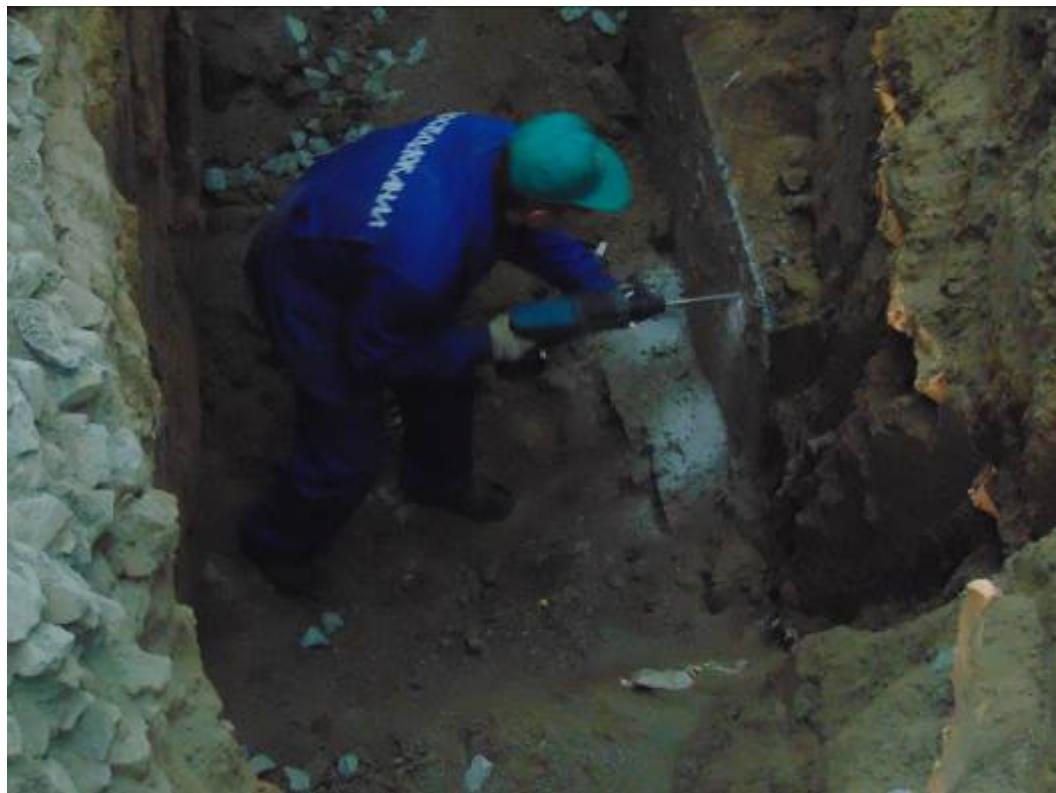
Фото 19. Шурф 1. Производится определение прочности бетона ростверков методом отрыва со скальванием.
