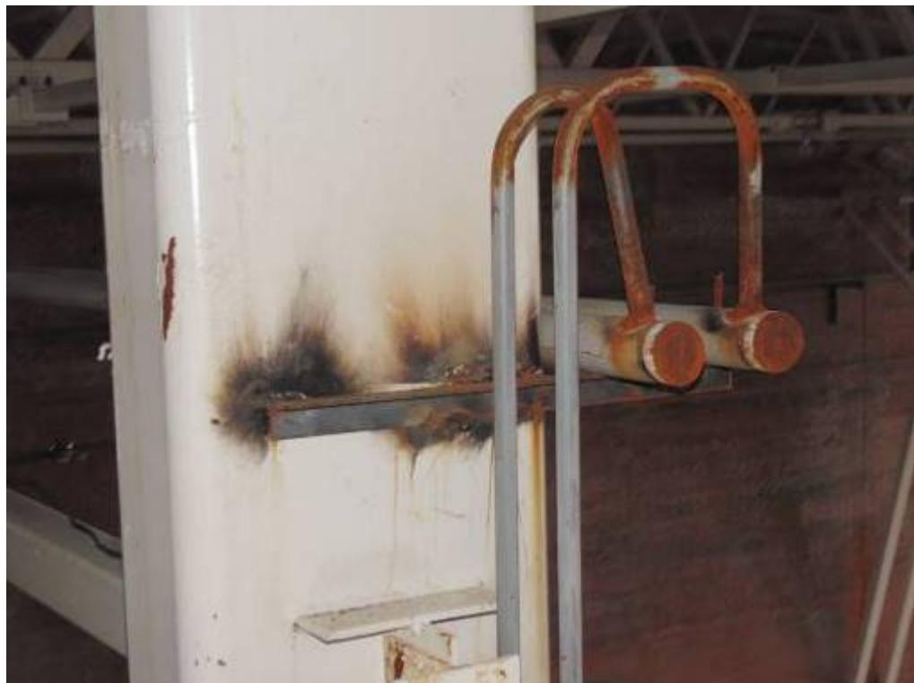
Фото 102. К колонне приварен прокатный уголок для опирания инженерных коммуникаций. Сварные швы выполнены с нарушением строительных норм. Узел крепления выполнен без разработки проектного решения.
