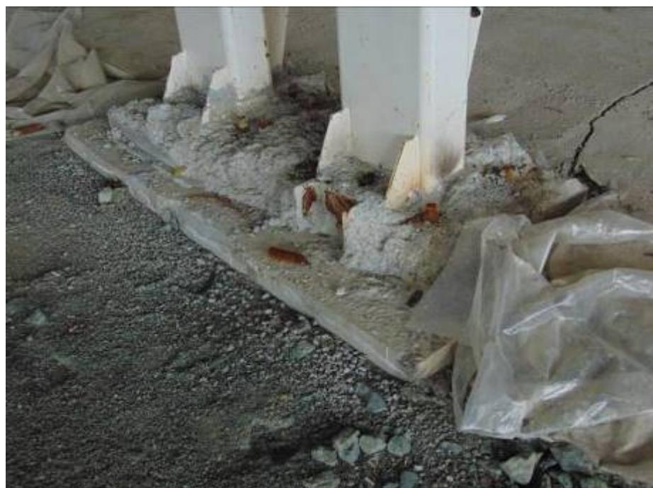
Фото 95. Узел опирания колонны на фундамент на участке температурного шва. Отсутствует антикоррозийное покрытие анкеров, шайб и гаек. Окрасочное (антикоррозийное) покрытие колонны повреждено, видны следы коррозии на колонне.
