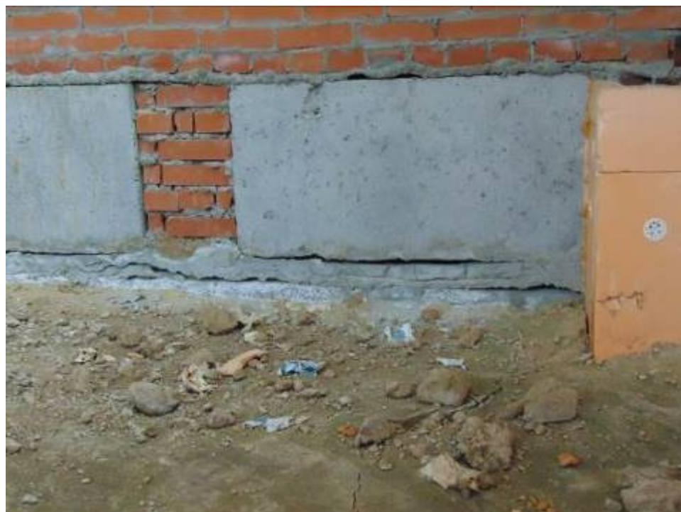
Фото 50. Фрагмент основания кирпичной стены вдоль осей В-Г, между осями 7-8. Основание выполнено из сборных бетонных стеновых фундаментных блоков. Видны трещины по швам укладки блоков шириной до 30мм возникшие в следствии просадок грунта-основания.
