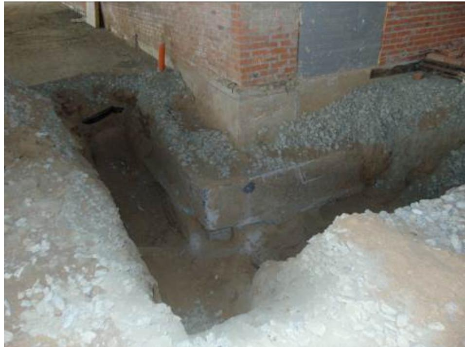
Фото 23. Шурф 3. Общий вид железобетонного монолитного ростверка. Видны забивные железобетонные сваи, а также фундаментная балка под кирпичную стену.
