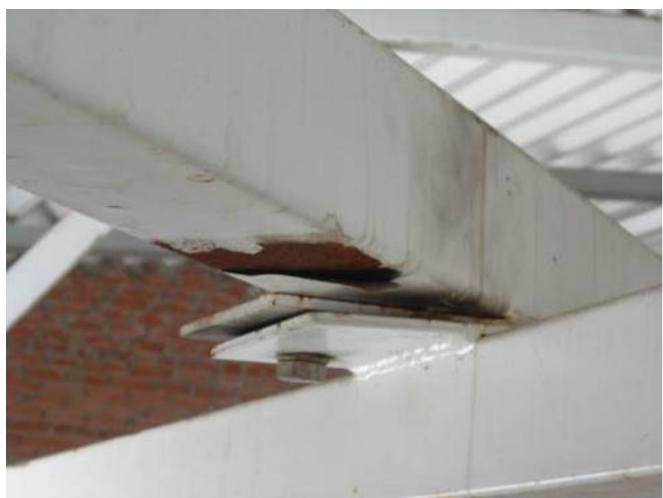
Фото 129. Узел крепления связи к ферме на участке в осях Ц-Э между осей 1-3 . Вследствие недостаточной затяжки гайки болтового соединения образовался зазор между монтажными деталями стыкуемых элементов. Повреждено окрасочное покрытие металлических конструкций. Видны следы коррозии.
