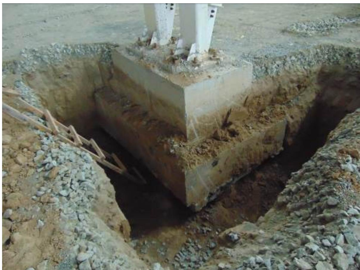
Фото 18. Шурф 1. Общий вид монолитного железобетонного ростверка.
