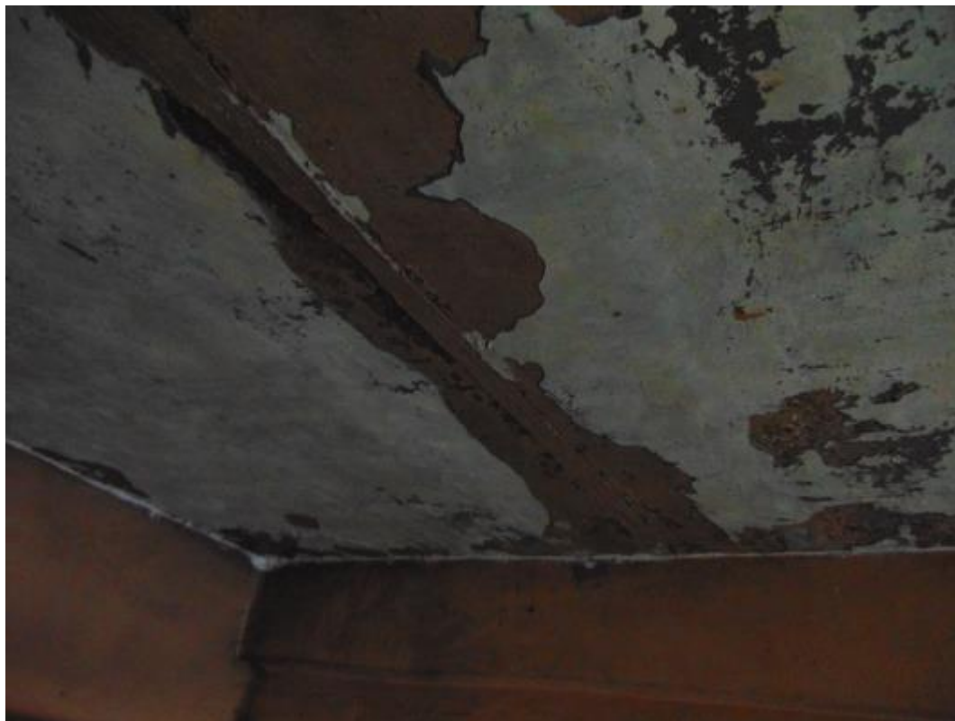
Фото 14. Выявлены множественные разрушения отделочного покрытия. Выявлены трещины по швам между плитами покрытия. Разрушений и деформаций самих плит покрытия не выявлено.
