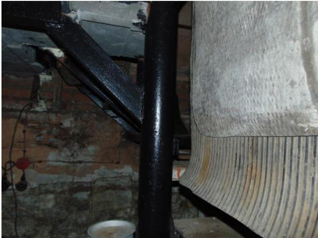
Фото 15. Лестница для сообщения между помещением для хранения автомобиля и подвалом. Разрушений и деформаций конструкций лестницы не выявлено.
