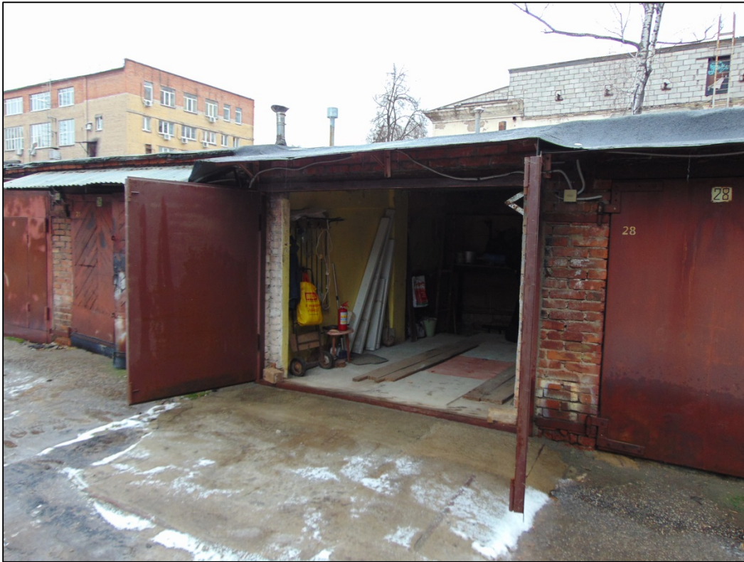
Фото 24. Въездные ворота. В результате проведенной экспертизы дефектов и повреждений конструкции ворот не выявлено.
