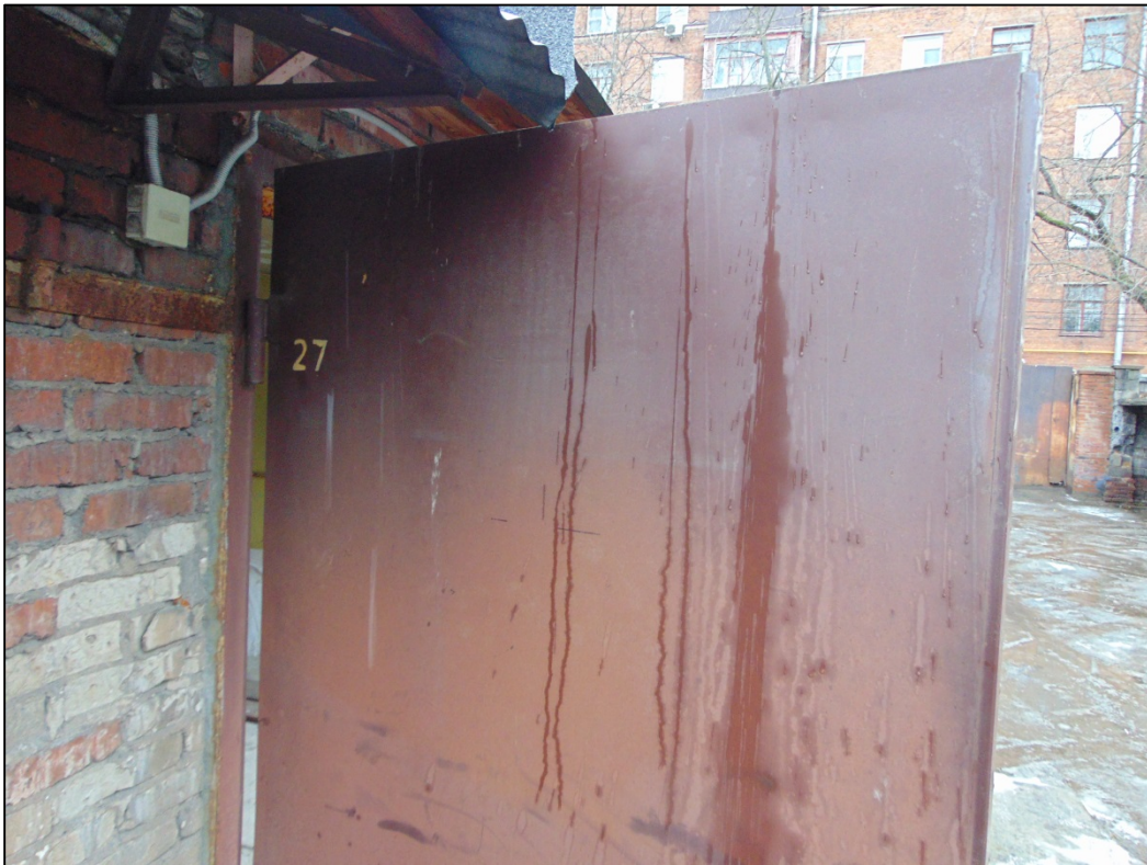
Фото 25. Въездные ворота. В результате проведенной экспертизы дефектов и повреждений конструкции ворот не выявлено.
