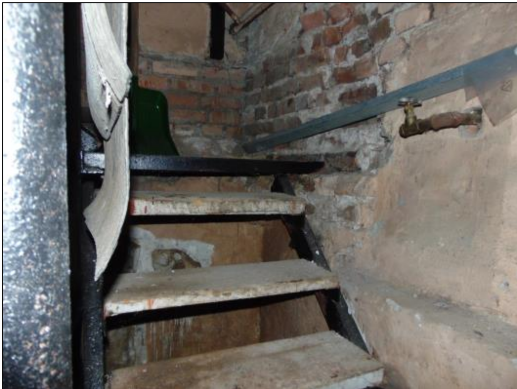
Фото 16. Лестница для сообщения между помещением для хранения автомобиля и подвалом. Разрушений и деформаций конструкций лестницы не выявлено.
