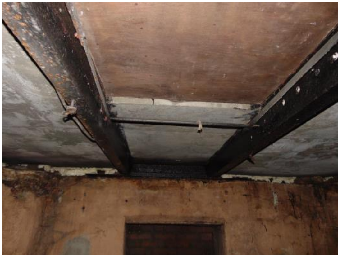
Фото 10. Перекрытие над подвалом. Разрушений и деформаций конструкций перекрытия не выявлено.
