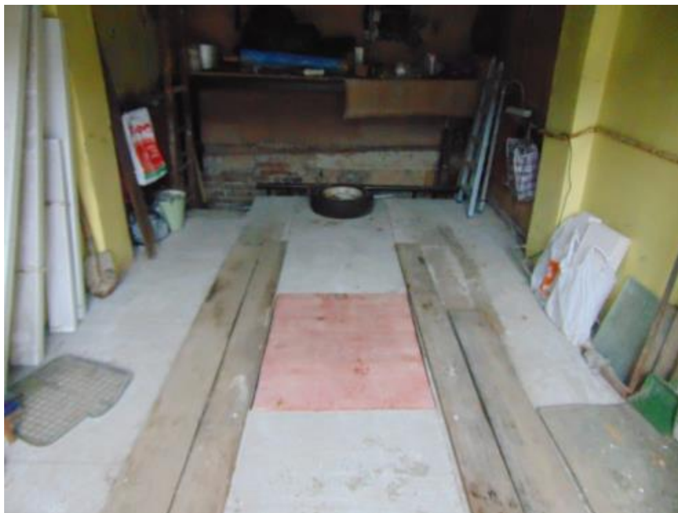
Фото 4. Помещение для хранения автомобиля. Повреждений, свидетельствующих о разрушении и деформации фундаментов, не выявлено.
