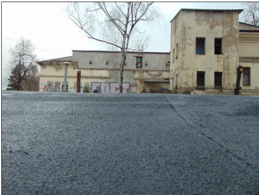
Фото 17. Кровельное покрытие бокса. Следов протечек не выявлено. Повреждений кровли не выявлено.
