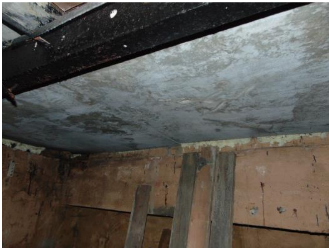
Фото 11. Перекрытие над подвалом. Разрушений и деформаций конструкций перекрытия не выявлено.
