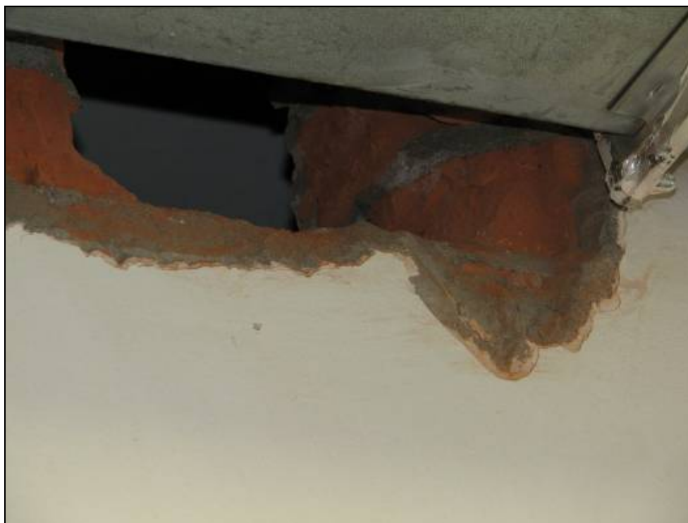
Фото 5. Кирпичная перегородка на участке расположения пищеблока.
