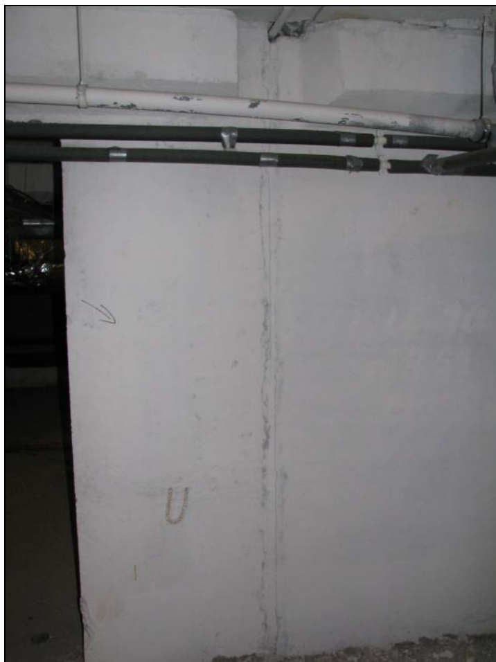
Фото 3. Стены в подвале из сборного железобетона.
