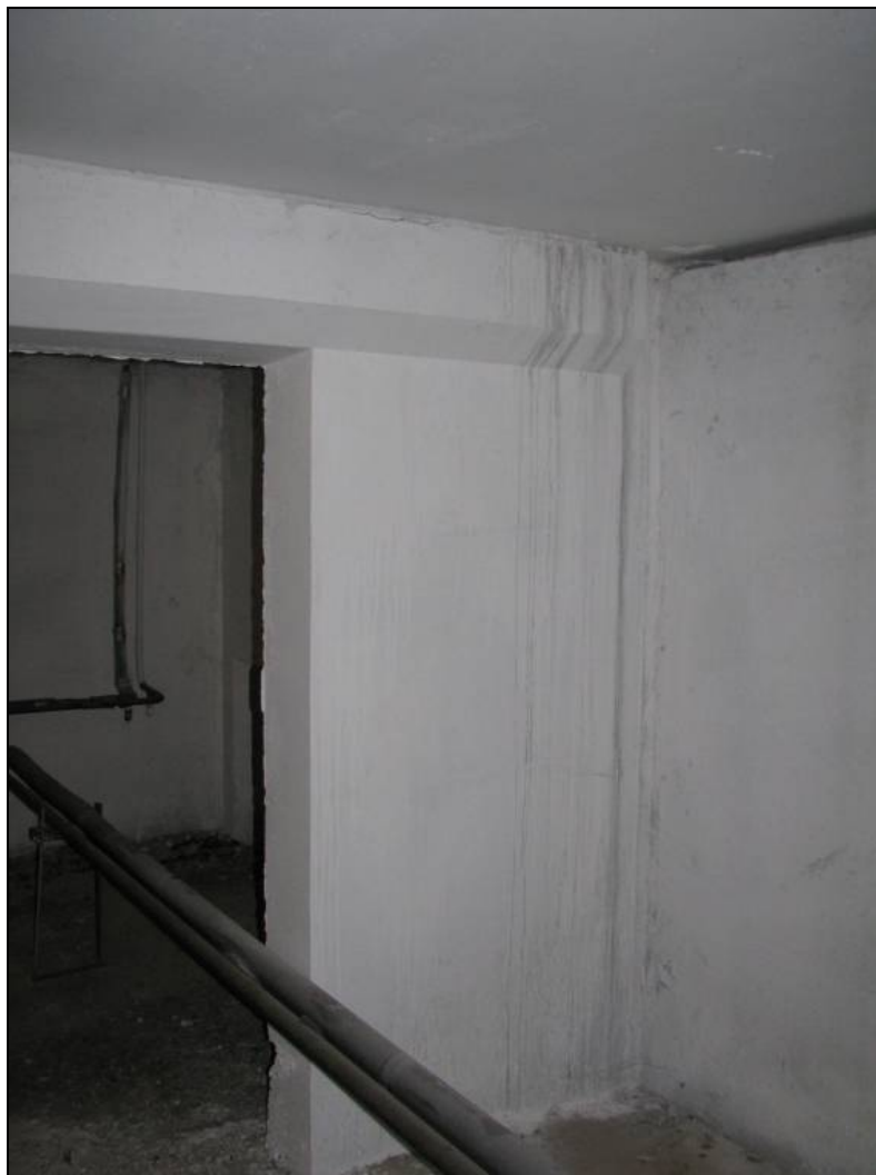
Фото 6. Узел опирания перекрытия на несущие стены подвала.
