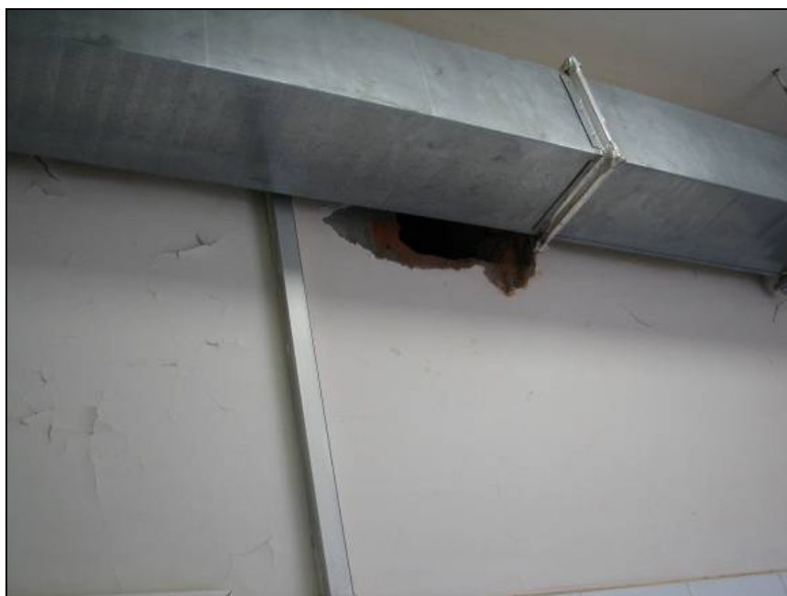
Фото 4. Кирпичная перегородка на участке расположения пищеблока.
