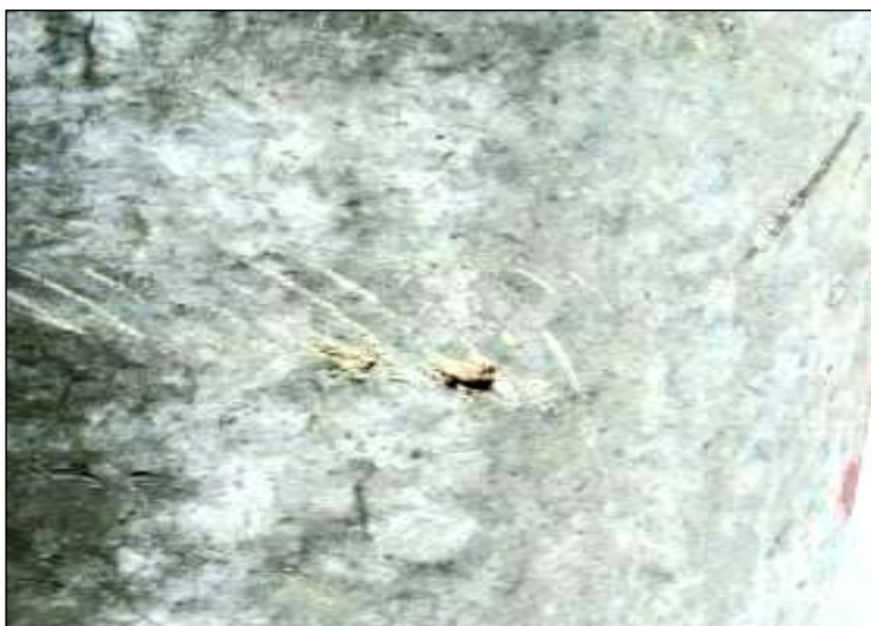
Фото 3. Раковина 10 x 10 x 10 мм, опора № 31
