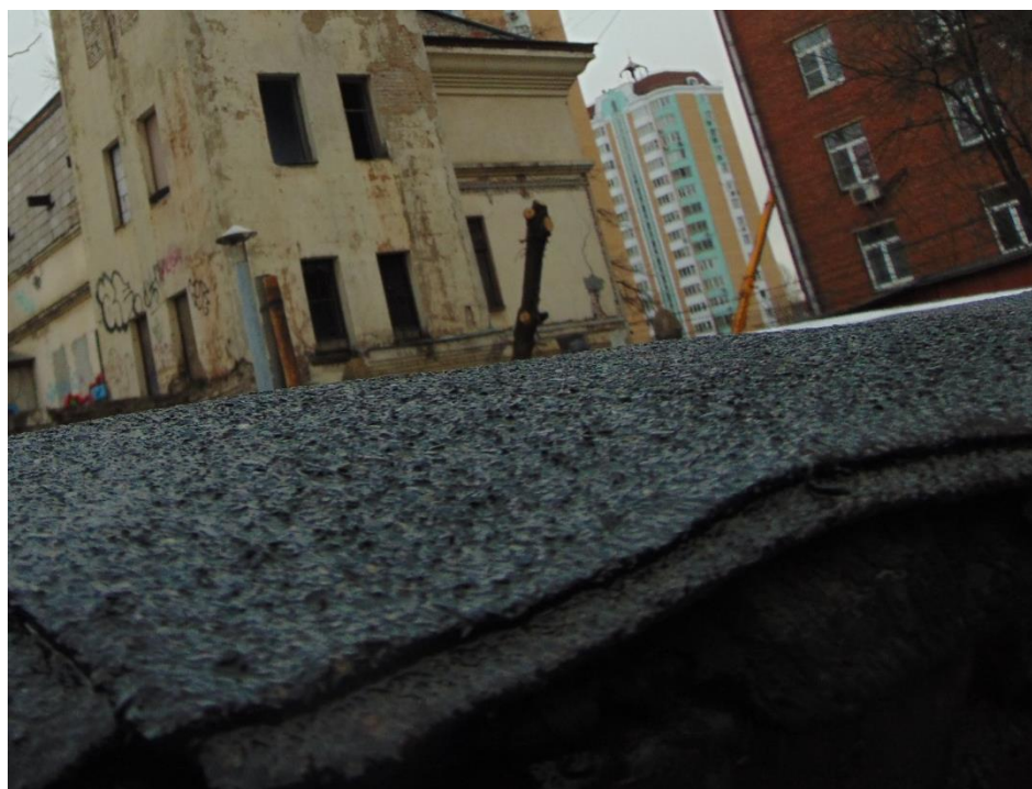
Фото 17. Кровельное покрытие бокса. Следов протечек не выявлено. Повреждений кровли не выявлено.
