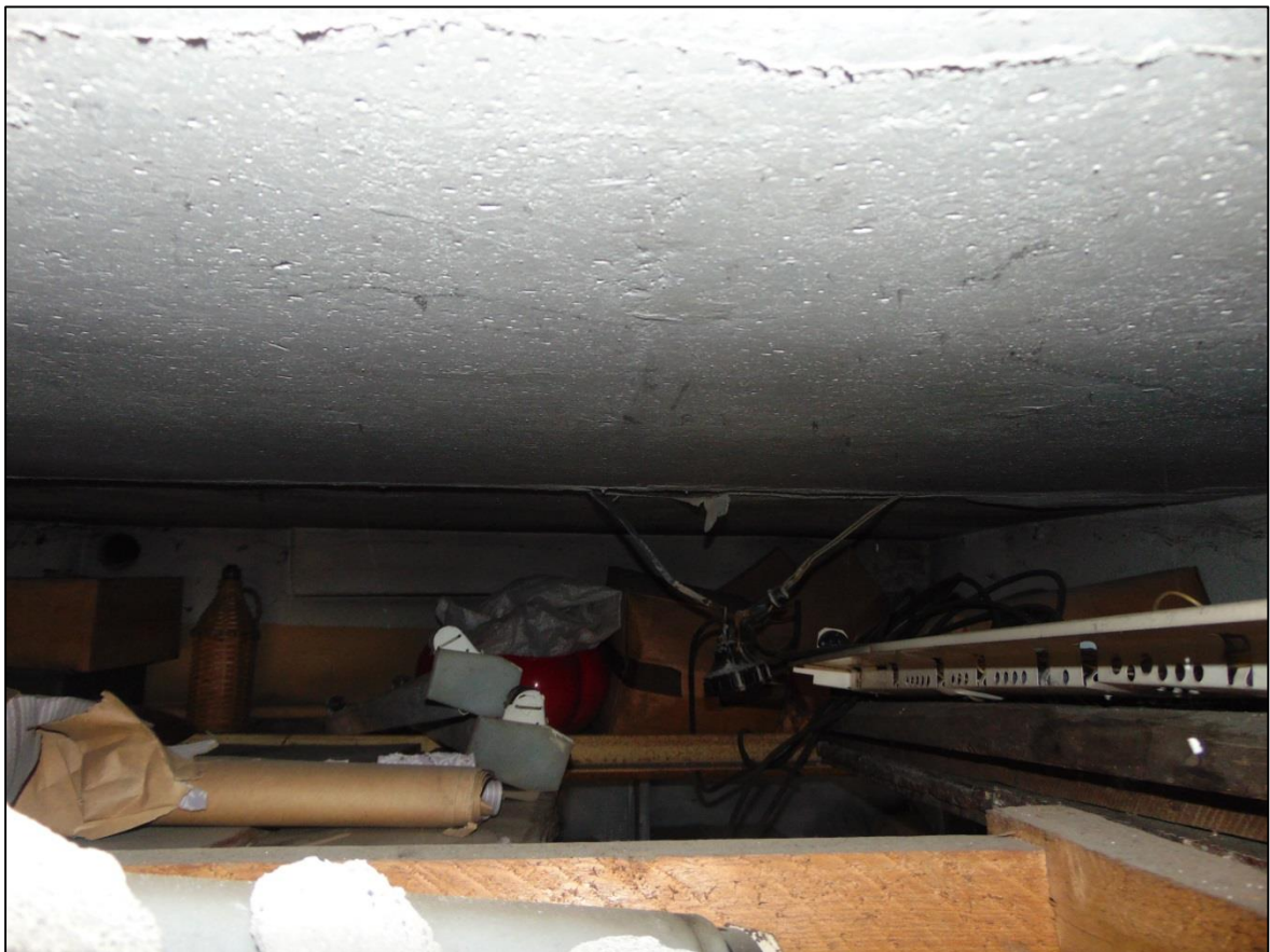
Фото 10. Плиты покрытия бокса. Разрушений и деформаций плит покрытия не выявлено.
