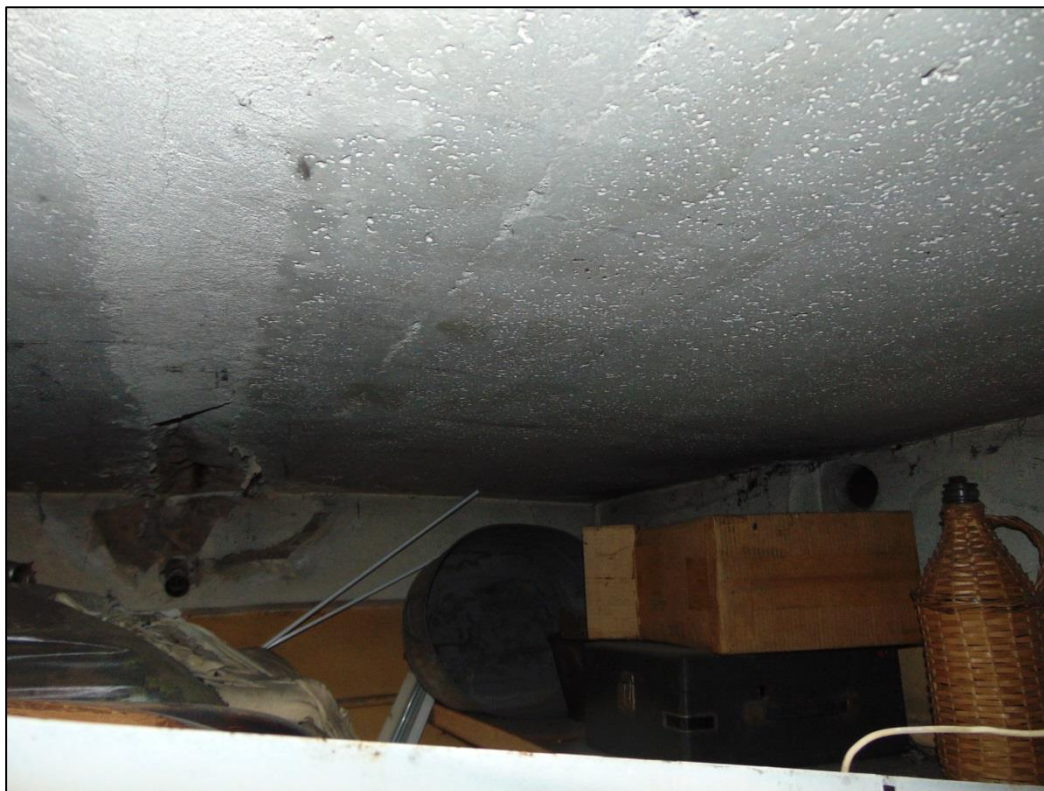
Фото 11. Плиты покрытия бокса. Разрушений и деформаций плит покрытия не выявлено.
