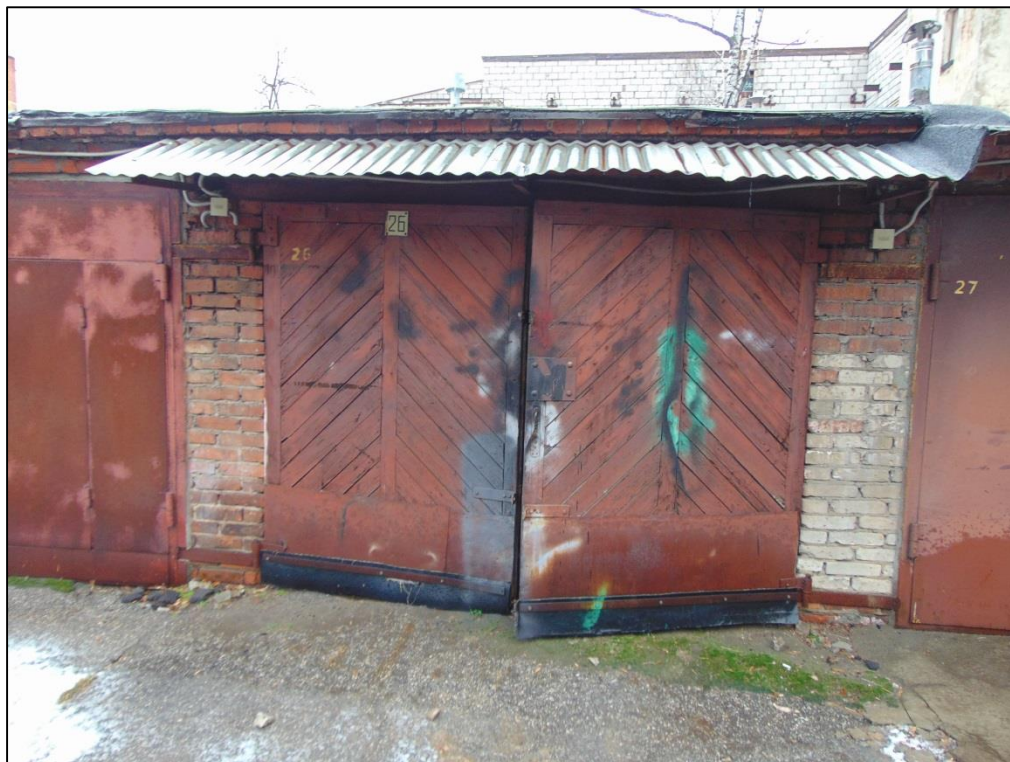
Фото 1. Наружные стены бокса. Признаков разрушений и деформаций конструкции фундаментов не выявлено.
