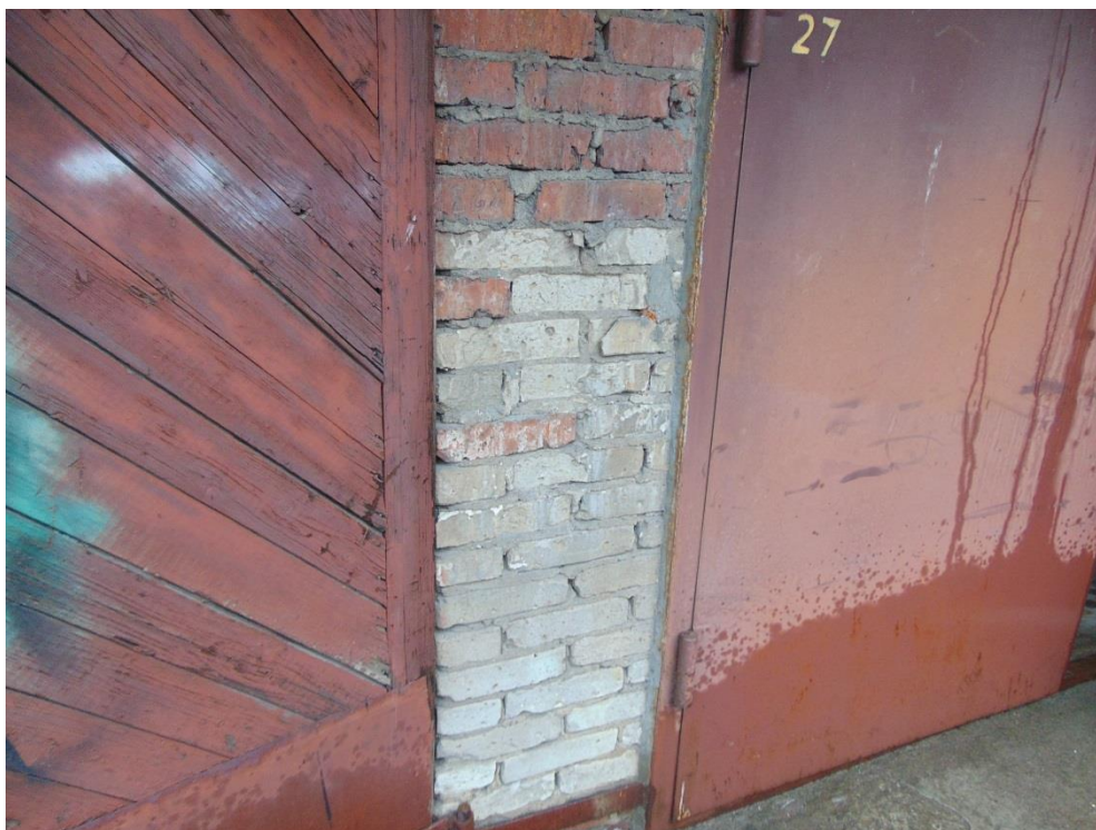
Фото 3. Цокольная часть наружных стен. Повреждений, свидетельствующих о разрушении и деформации фундаментов, не выявлено.
