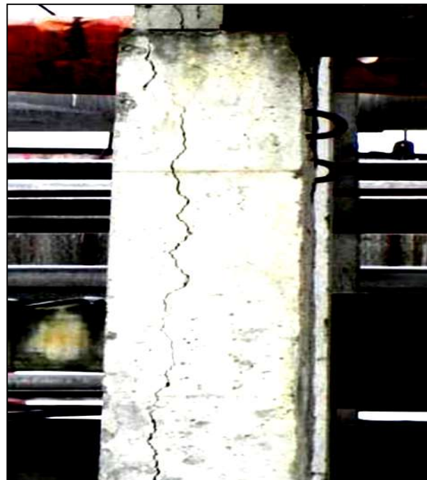
Фото 9, 10. Двухступенчатая колонна К2 в осях «А/39». Верхняя часть разгружена – продольные трещины шириной раскрытия до 20 мм. Нижняя часть – продольные трещины шириной раскрытия 1-15 мм протяженностью до 2 м. Коррозия арматуры колонны. Растрескивание бетона в результате смятия опорной зоны под металлическим ригелем. Разрушение антикоррозионной защиты, питтинговая и язвенная коррозия ригеля.
