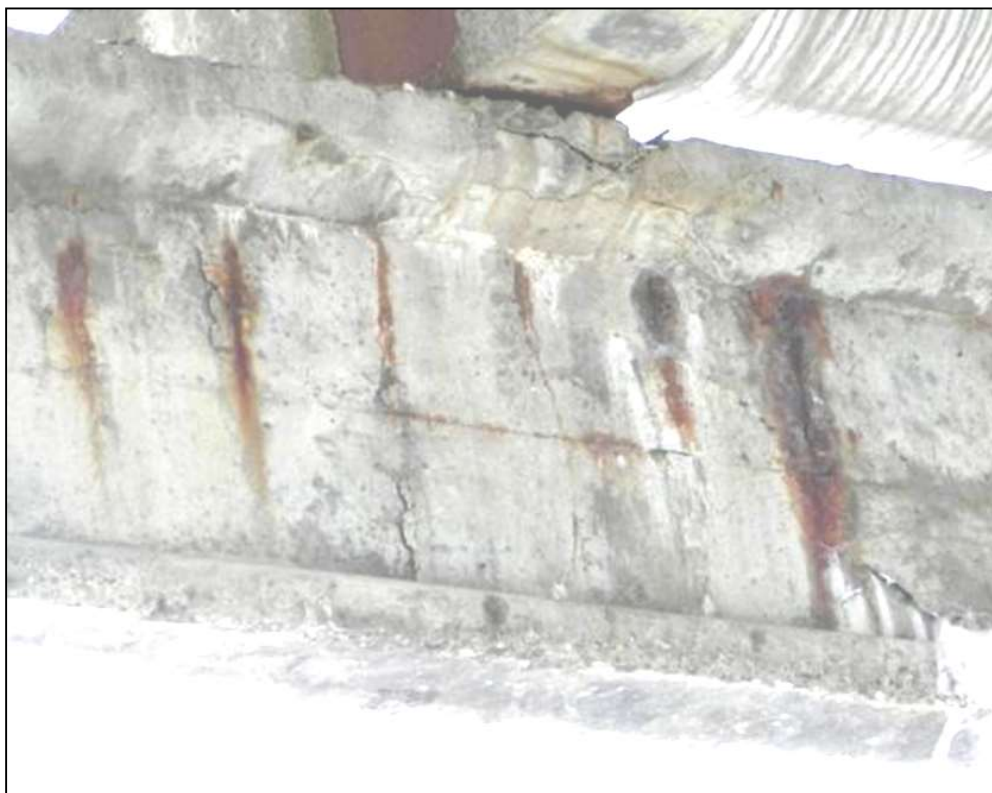
Фото 3. Смятие сжатой полки двутаврового ригеля. Трещины стенки балки в осях «В/5-6»; лещадка: следы коррозии арматуры и выщелачивания бетона.
