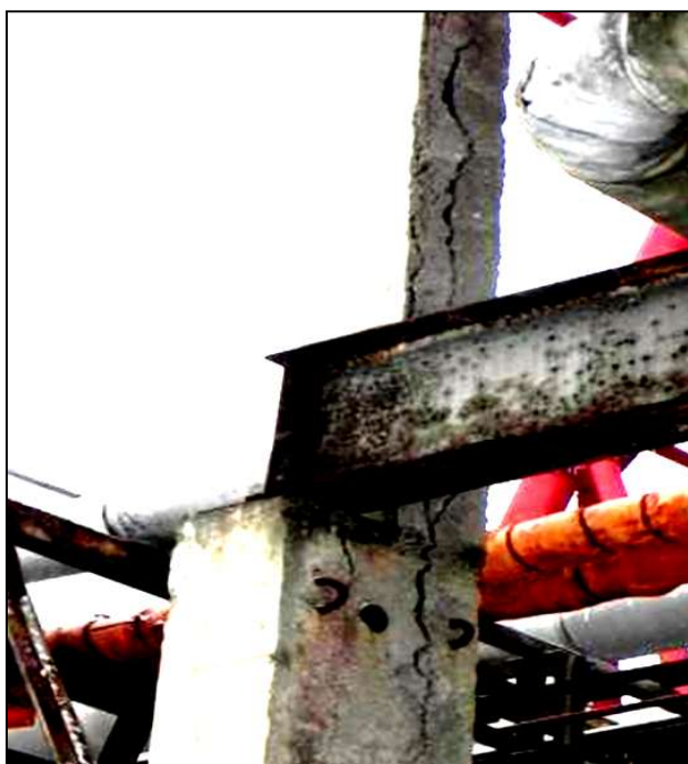
Фото 9, 10. Двухступенчатая колонна К2 в осях «А/39». Верхняя часть разгружена – продольные трещины шириной раскрытия до 20 мм. Нижняя часть – продольные трещины шириной раскрытия 1-15 мм протяженностью до 2 м. Коррозия арматуры колонны. Растрескивание бетона в результате смятия опорной зоны под металлическим ригелем. Разрушение антикоррозионной защиты, питтинговая и язвенная коррозия ригеля.
