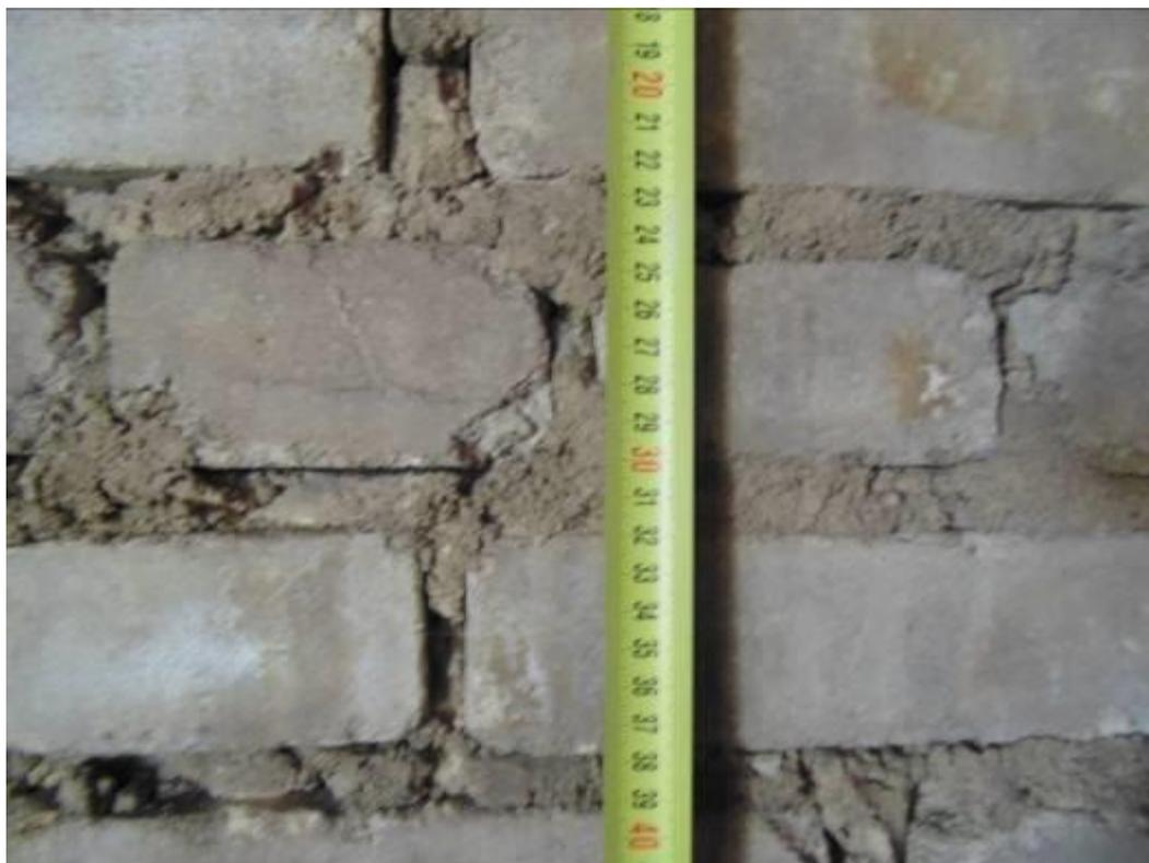
Фото 41. Толщина швов кирпичной кладки превышает допустимые 15мм.
