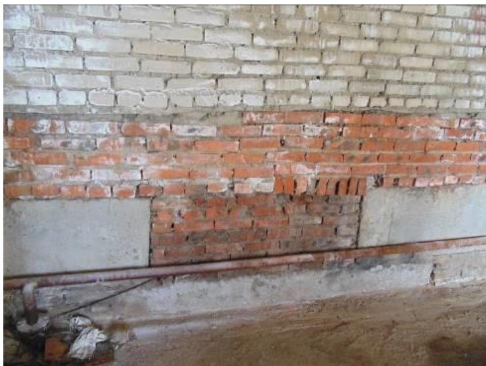
Фото 22. Нарушена горизонтальность рядов и толщина швов кирпичной кладки. По причине сильного нарушения горизонтальности рядов отклонение кладки компенсировано укладкой кирпича боковой стороной (на ложок).
