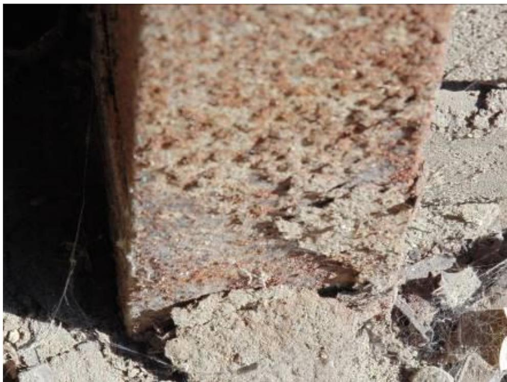
Фото 35. Наличие глубокой коррозии на металлических элементах обоймы колонны.
