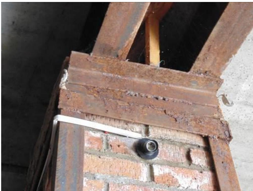
Фото 60. Опираение балки на колонну производится через элементы металлического каркаса. Металлические элементы значительно поражены коррозией.
