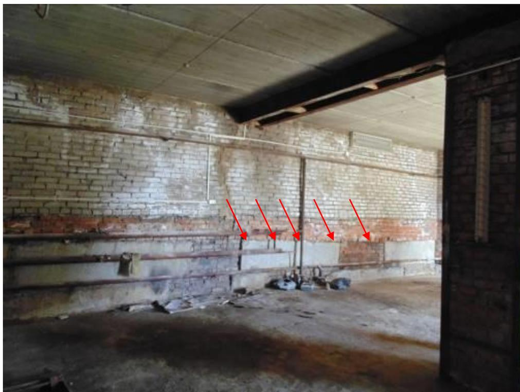
Фото 14. Деформации стен в следствии просадки фундамента.
