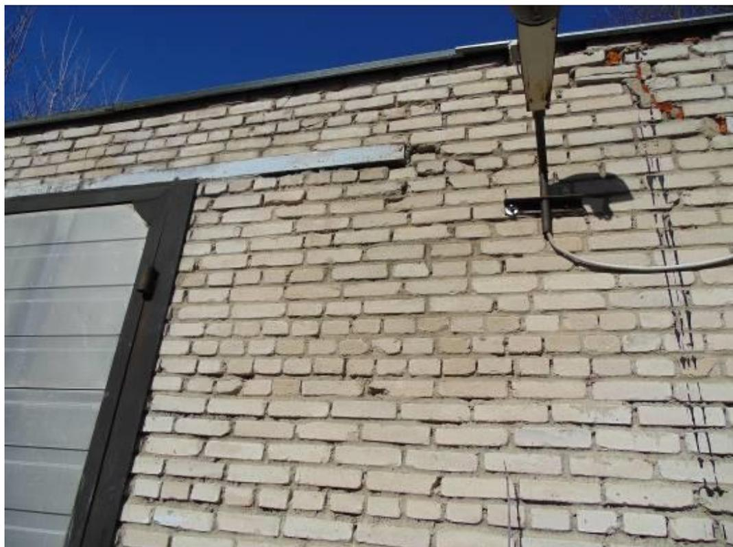
Фото 49. Разрушения кирпичной кладки по фасаду. Выветривание раствора из швов кирпичной кладки.
