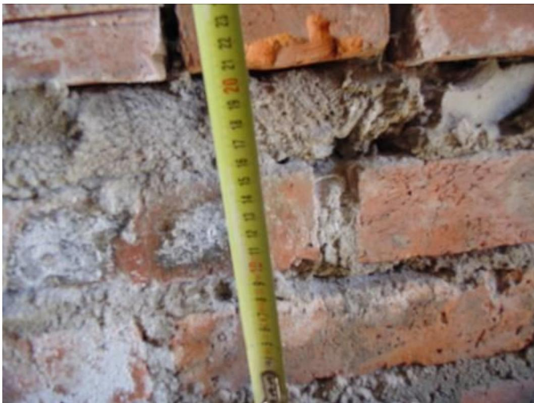
Фото 45. Толщина швов кладки стен значительно превышает допустимые 15мм.
