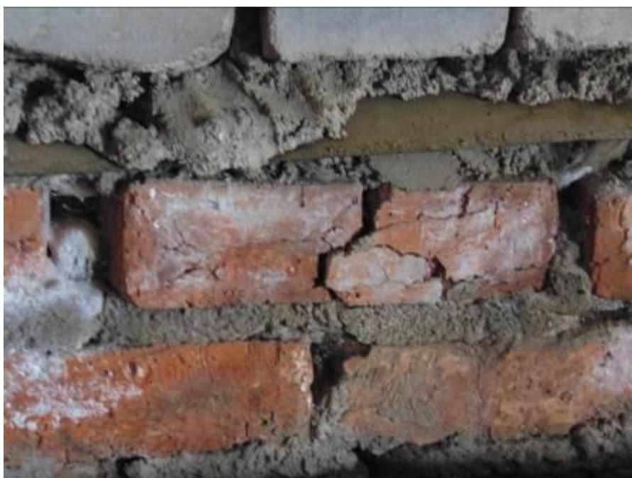
Фото 24. Разрушение отдельных кирпичей кладки стен.
