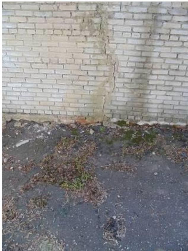
Фото 57. Сквозная трещина в стене и асфальтовом покрытии по причине деформации грунтов.
