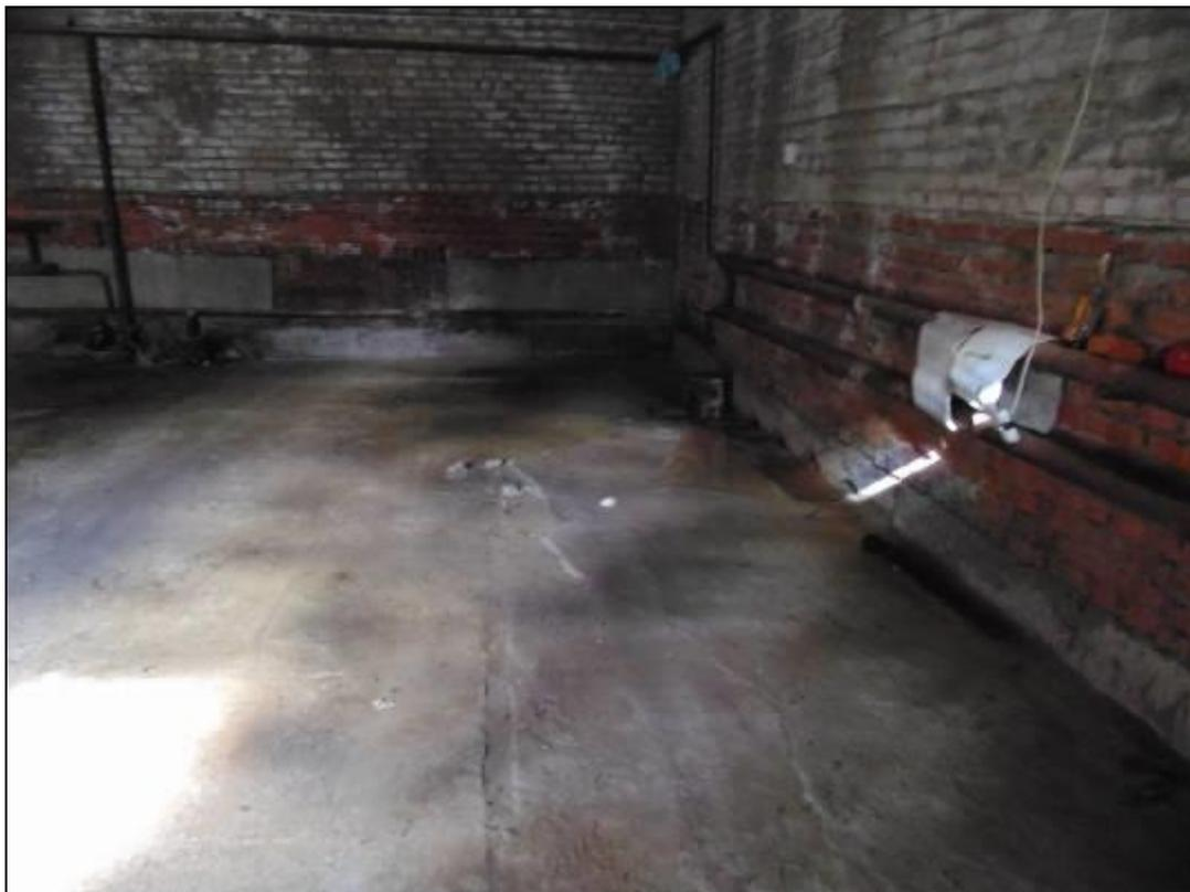
Фото 62. Трещины и деформации пола в следствии просадок основания.
