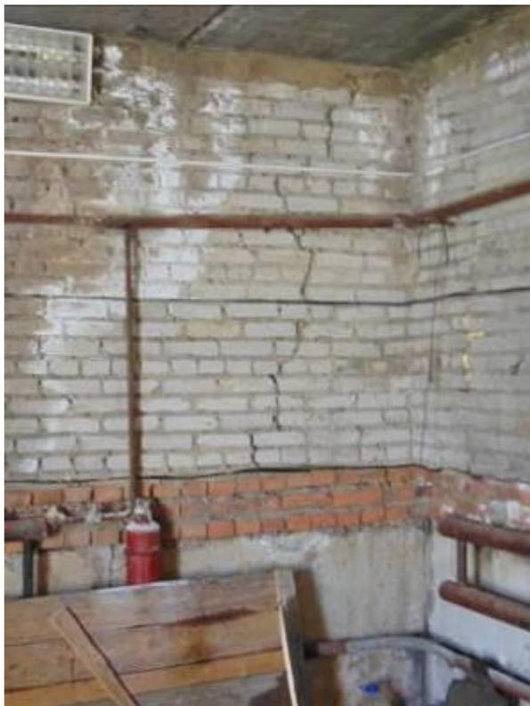
Фото 27. Сквозная трещина в стене. Наличие высалов на поверхности стены по причине длительных протечек.
