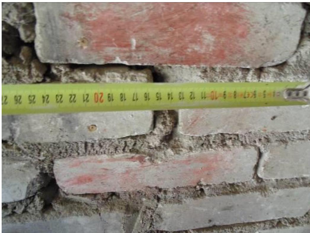
Фото 43. Толщина швов кирпичной кладки превышает допустимые 15мм. Растрескивание кирпичной кладки.
