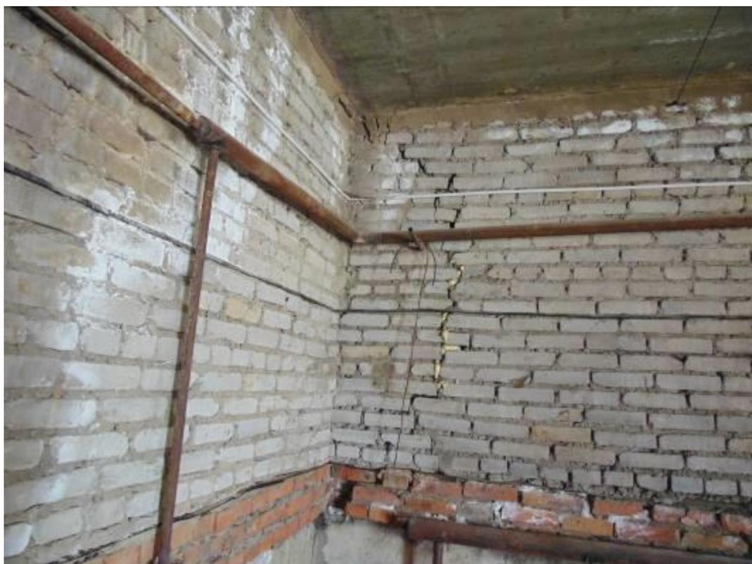
Фото 48. Сквозная трещина в стене.
