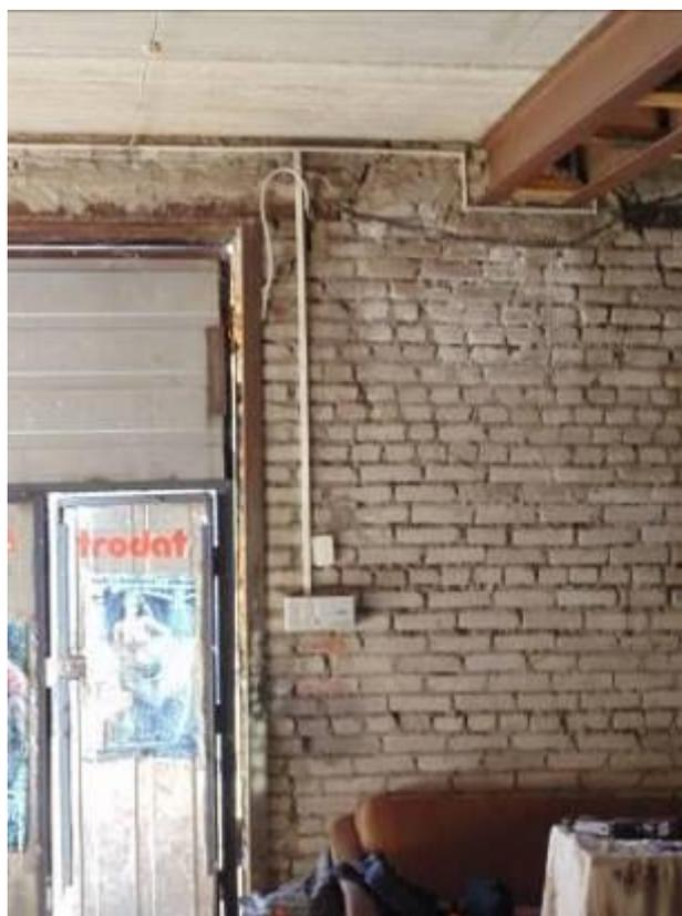
Фото 28. Трещины в кирпичной кладке стен.
