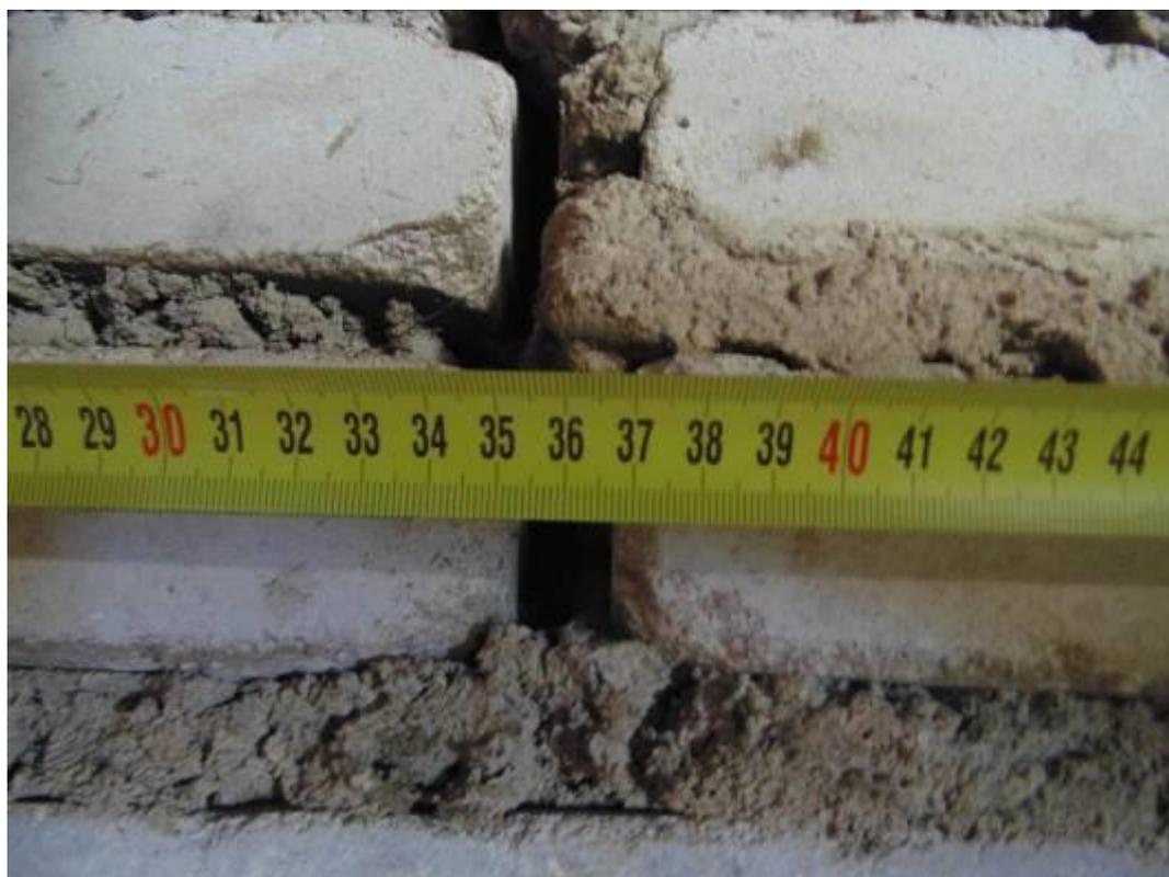
Фото 40. Сквозная трещина в стене шириной до 16мм.
