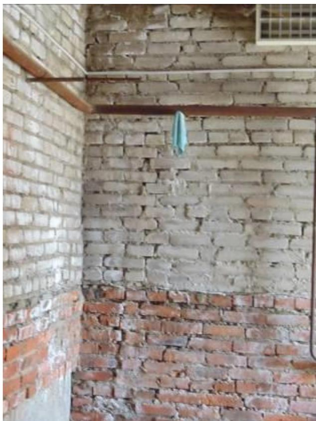
Фото 26. Сквозная трещина в стене.
