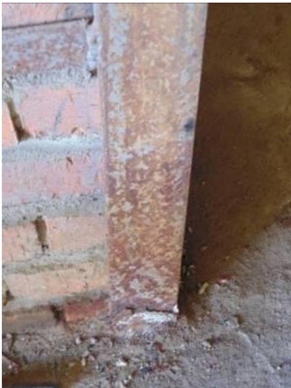
Фото 33. Наличие глубокой коррозии на металлических элементах обоймы колонны.
