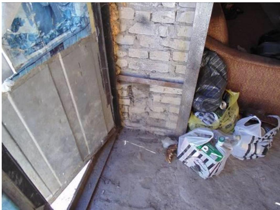
Фото 36. Разрушение кирпичной кладки стен.
