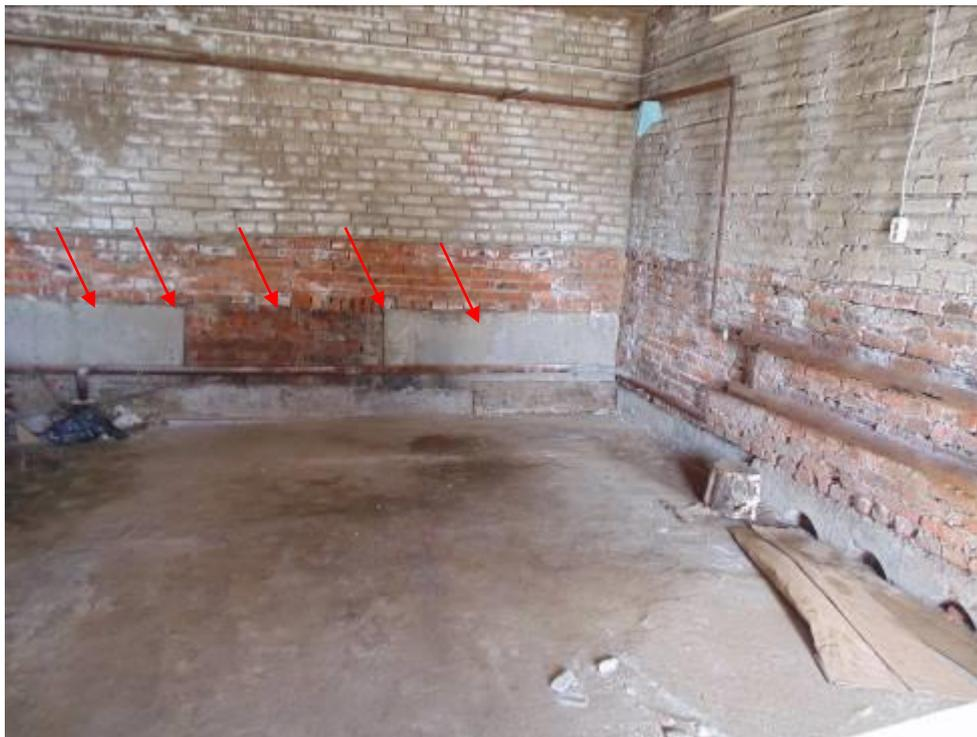
Фото 13. Деформации стен в следствии просадки фундамента.
