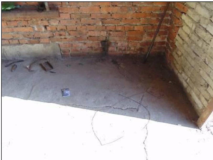
Фото 11. Трещины в конструкции пола в следствии просадки фундамента.
