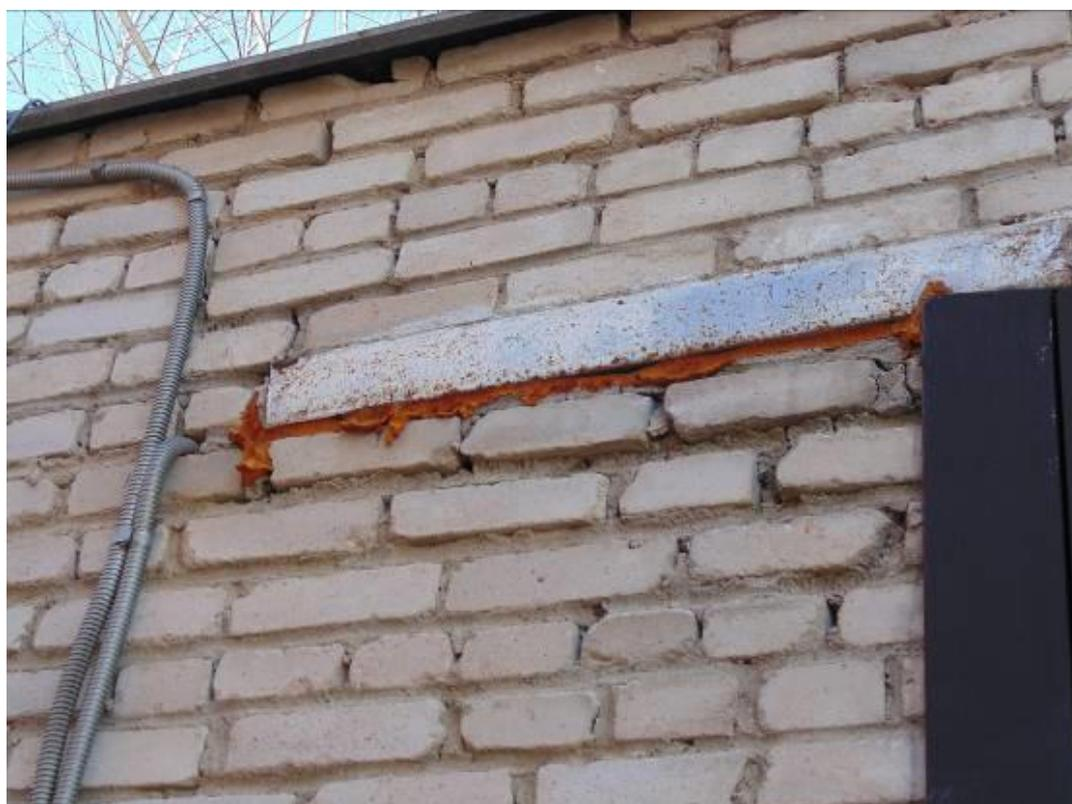
Фото 50. Трещина кирпичной кладки под балкой перекрытия ворот.
