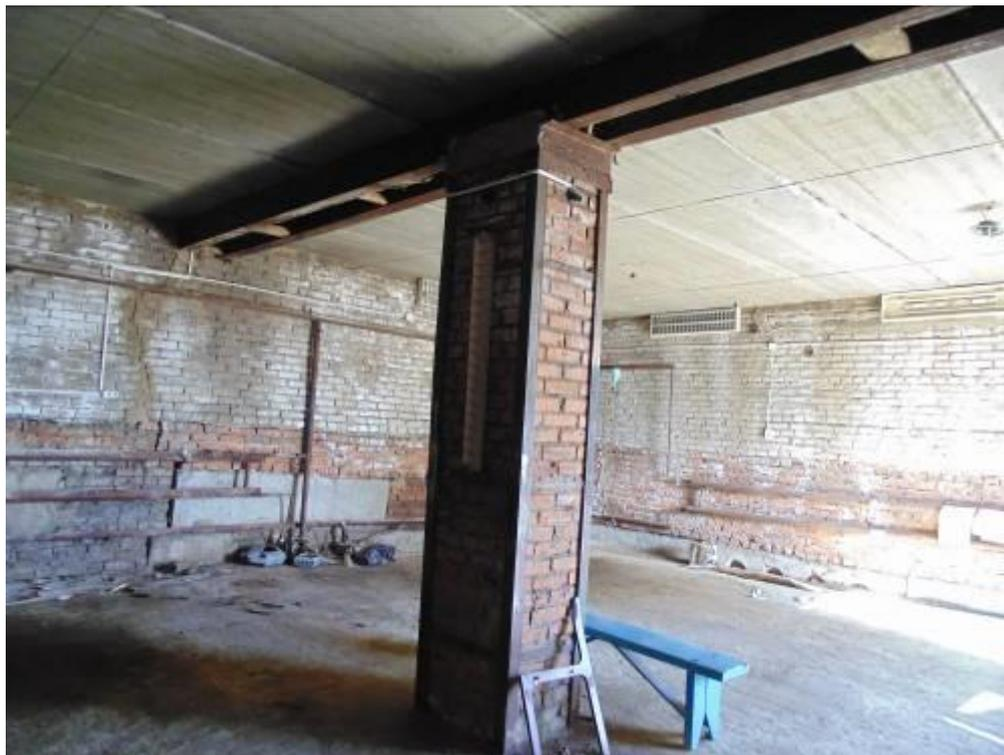
Фото 59. Сборные многопустотные железобетонные плиты перекрытия опираются на кирпичные стены и металлическую балку.
