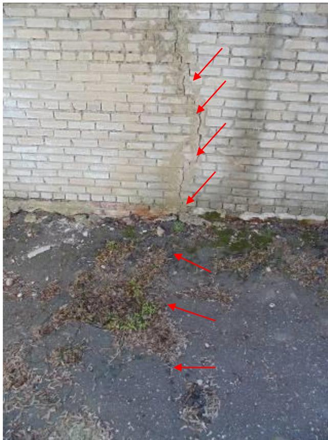
Фото 17. Трещины в наружных стенах в следствии деформаций грунта основания.
