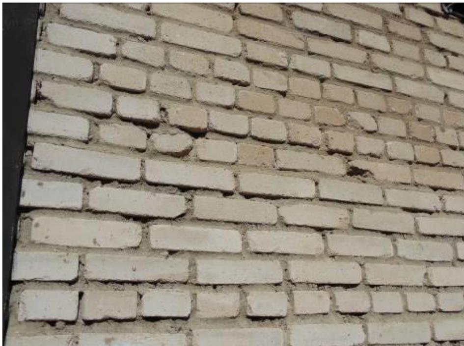
Фото 51. Выветривание раствора из швов кирпичной кладки по фасаду.
