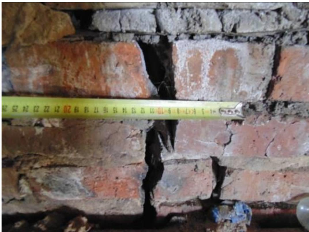
Фото 38. Сквозная трещина в стене шириной до 30мм.
