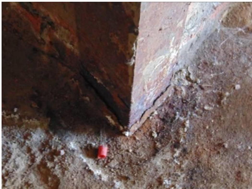
Фото 31. Наличие глубокой коррозии на металлических элементах обоймы колонны.
