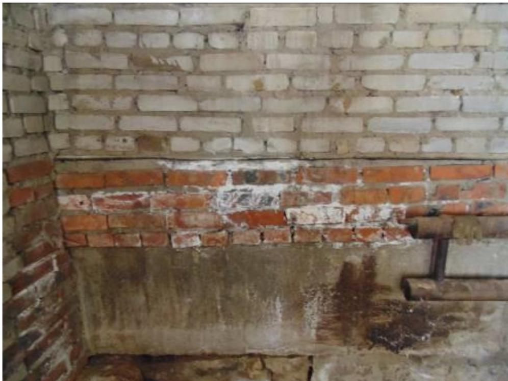
Фото 19. Высолы на поверхности стен в следствии протечек.
