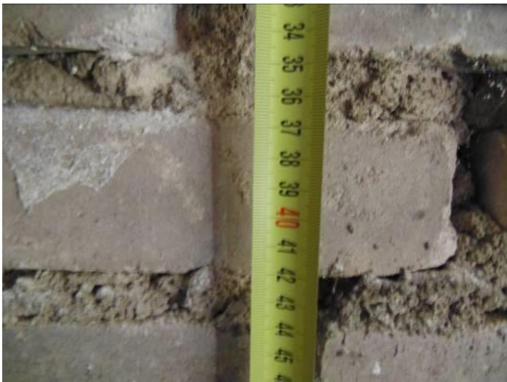
Фото 39. Толщина швов кирпичной кладки превышает допустимые 15мм.
