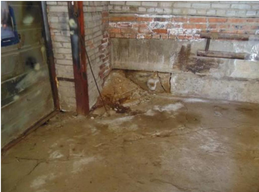
Фото 61. Трещины и деформации пола в следствии просадок основания.
