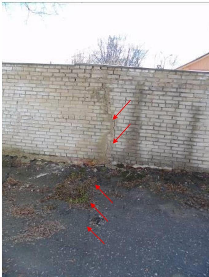
Фото 16. Трещины в наружных стенах в следствии деформаций грунта основания.
