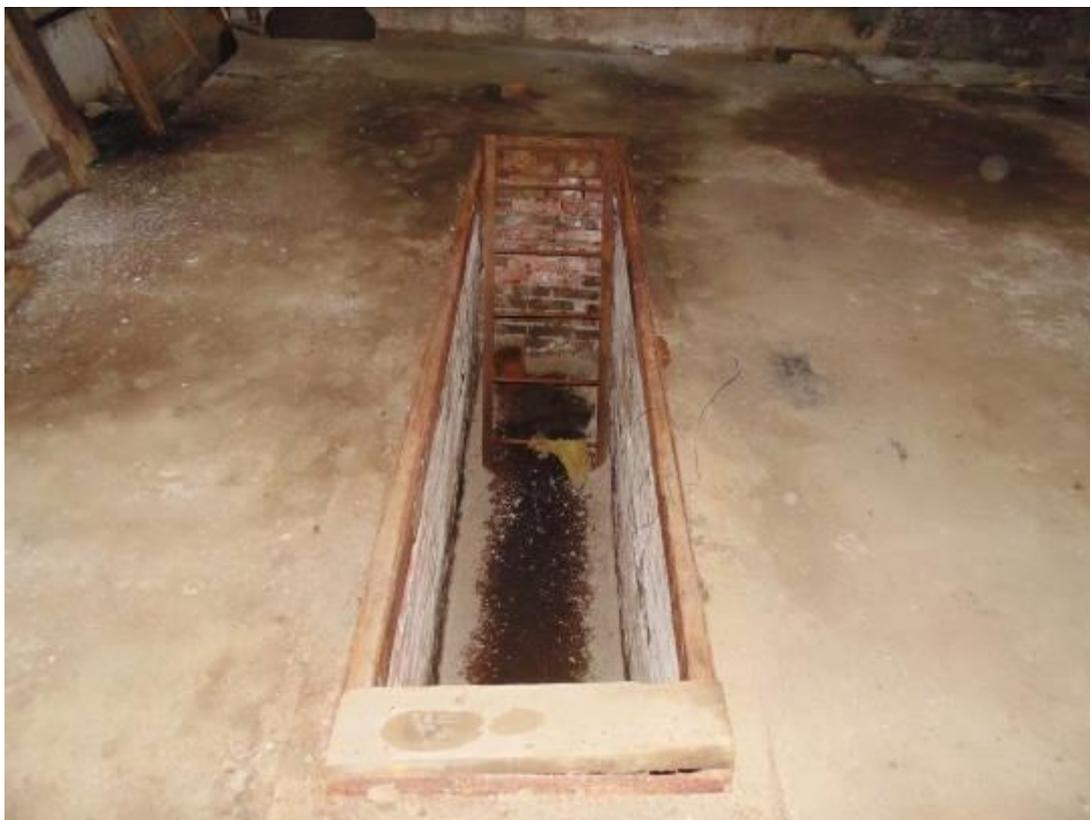
Фото 63. Яма в конструкции пола для обслуживания и ремонта автомобилей.
