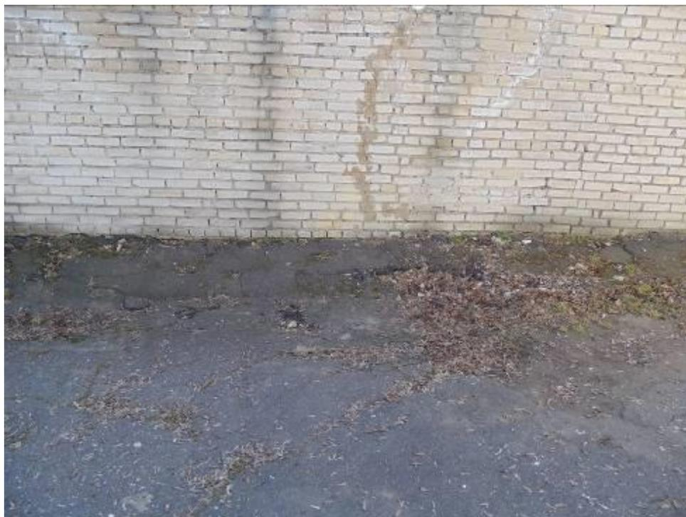
Фото 58. Сквозная трещина в стене и асфальтовом покрытии по причине деформации грунтов.
