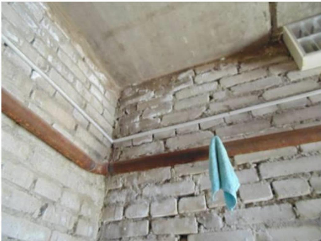
Фото 47. Высолы на поверхности стен по причине длительных протечек.
