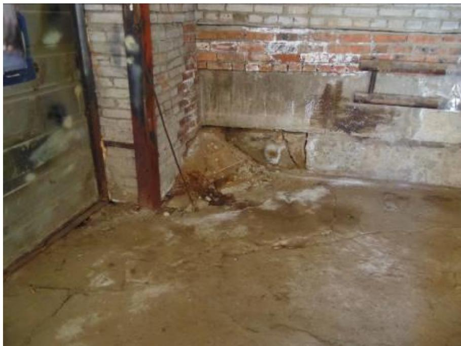
Фото 12. Трещины в конструкции пола, разрушение и деформации фундамента в следствии просадки.
