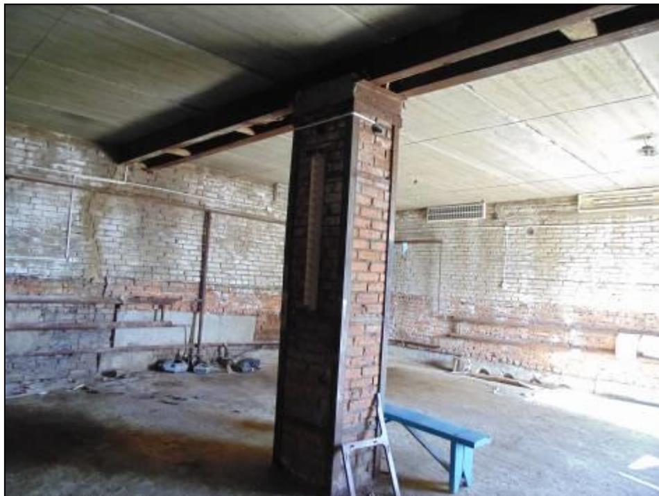
Фото 29. Кирпичная колонна усилена металлической обоймой.
