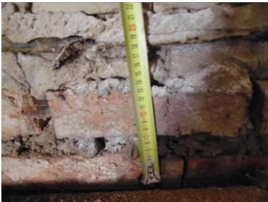
Фото 42. Толщина швов кирпичной кладки превышает допустимые 15мм.
