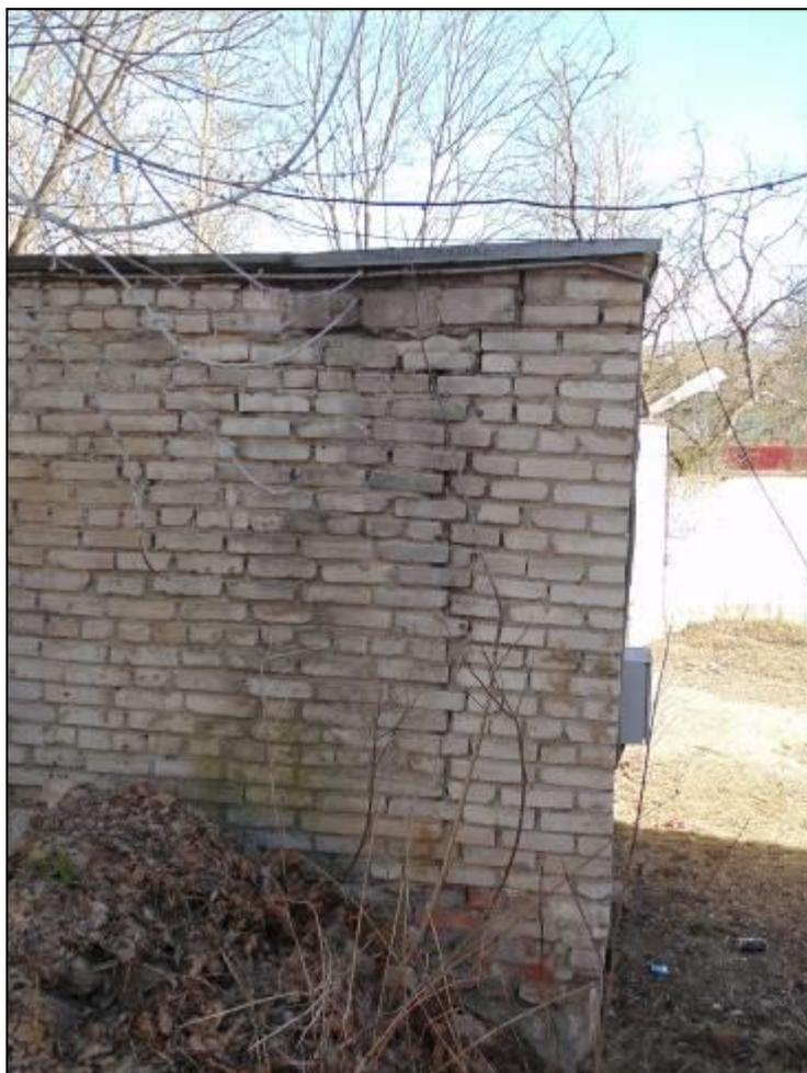
Фото 52. Сквозная трещина в стенах по причине просадки фундамента.
