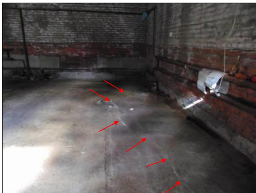
Фото 18. Трещины в конструкции пола по причине просадки грунта.
