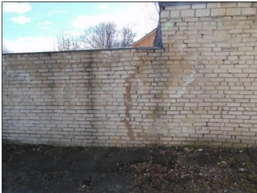
Фото 55. Сквозная трещина в стенах.
