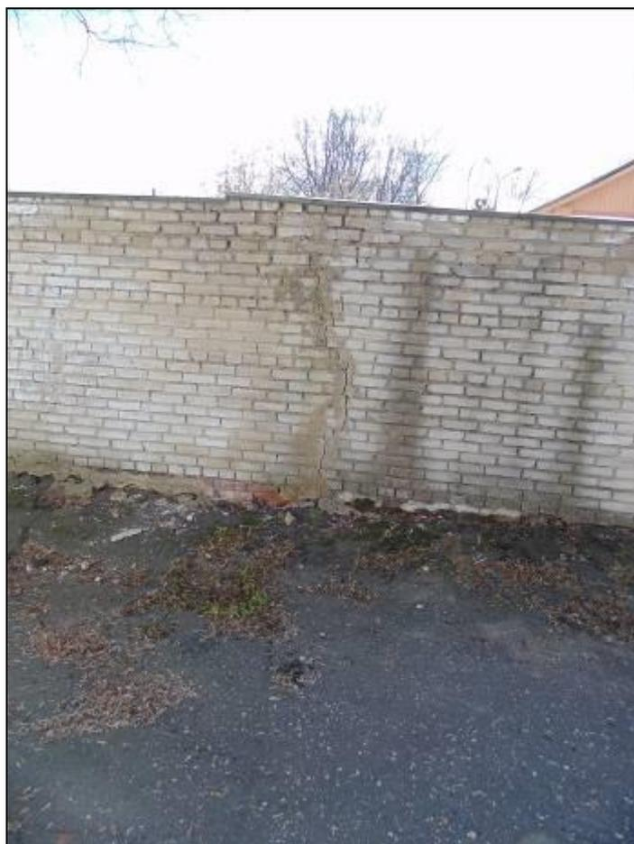
Фото 56. Сквозная трещина в стене и асфальтовом покрытии по причине деформации грунтов.
