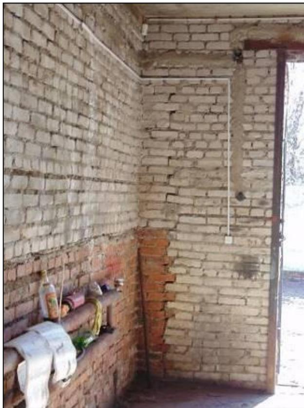
Фото 25. Растрескивание и деформация стен по причине просадок фундамента.
