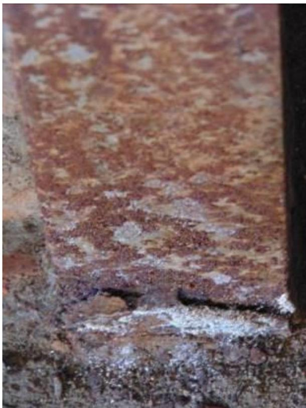
Фото 34. Наличие глубокой коррозии на металлических элементах обоймы колонны.
