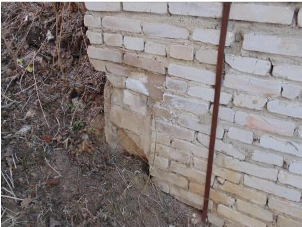
Фото 15. Разрушение цокольной части стен здания.
