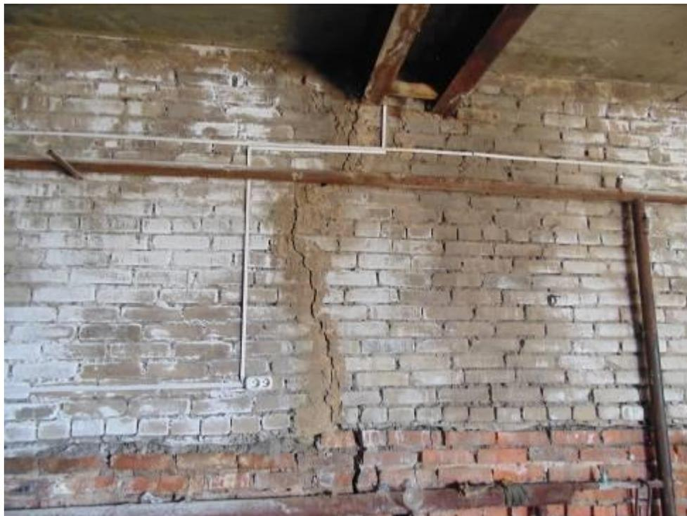
Фото 21. Высолы на поверхности стен. Сквозные трещины в стенах по причине деформаций и просадок фундаментов.
