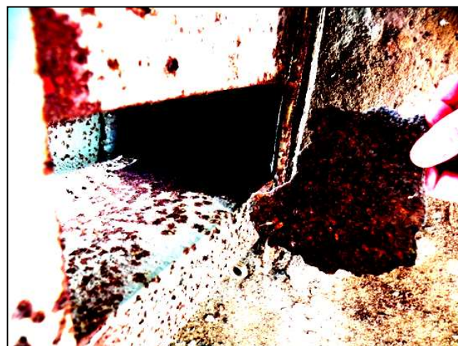
Фото 11, 12. Металлические конструкции (стойки) в отм. 4,300-4,400 м по всей длине эстакады. Разрушение антикоррозионной защиты. поверхностная точечная и слоисто-пластинчатая коррозия стоек.
