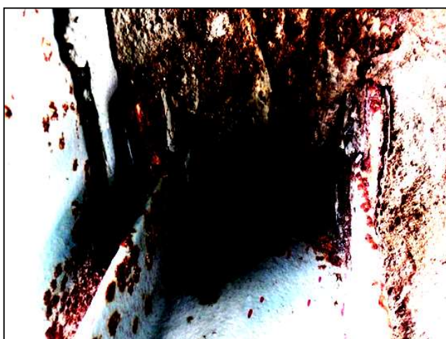
Фото 11, 12. Металлические конструкции (стойки) в отм. 4,300-4,400 м по всей длине эстакады. Разрушение антикоррозионной защиты. поверхностная точечная и слоисто-пластинчатая коррозия стоек.
