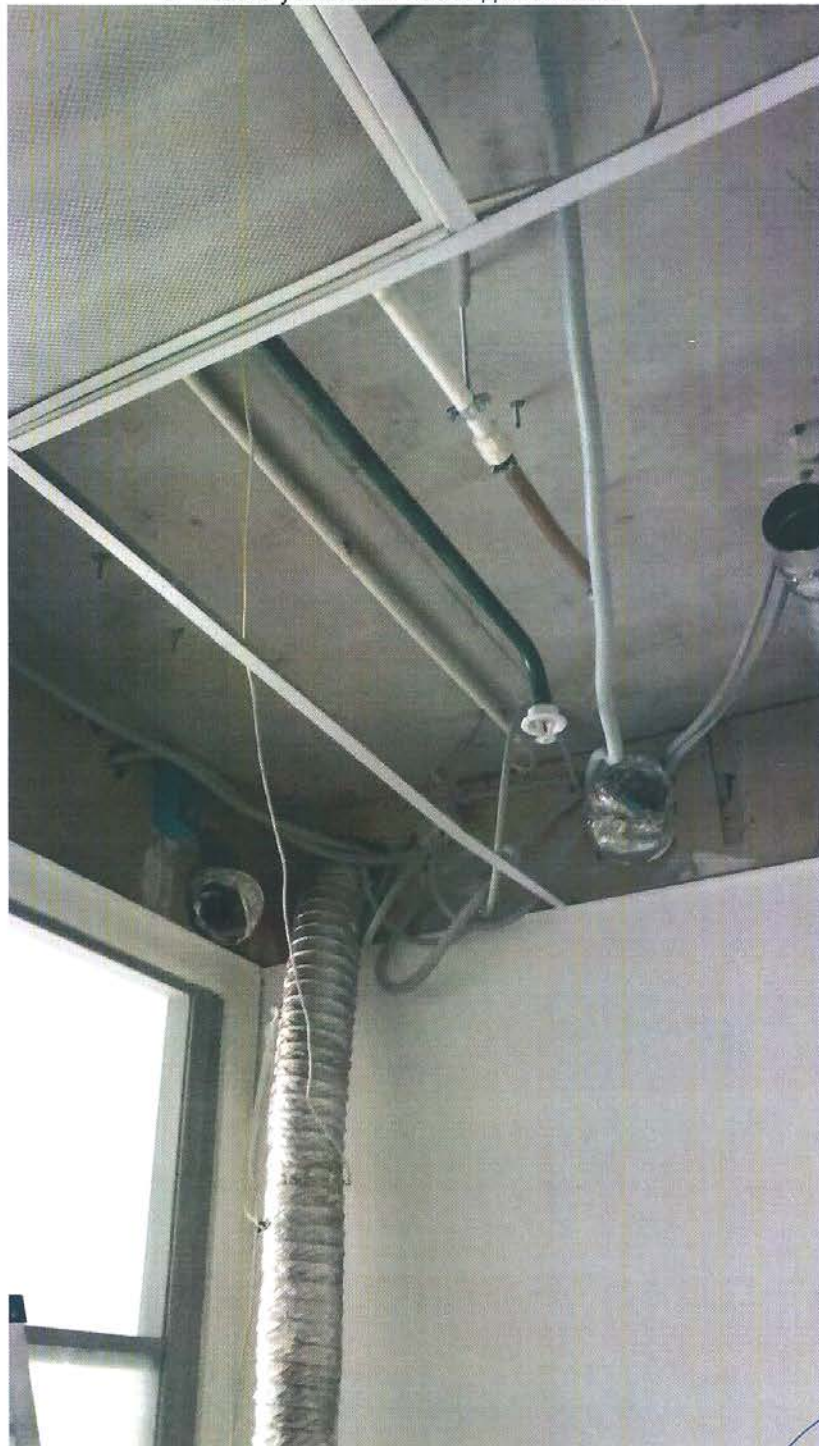
3. Место установки после демонтажа:
