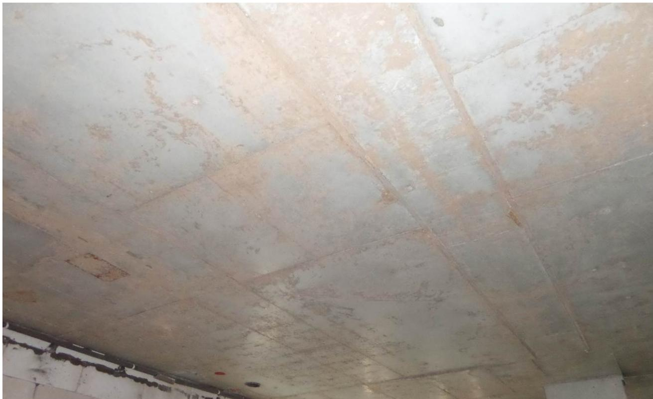
Фото 14. Монолитное железобетонное перекрытие
