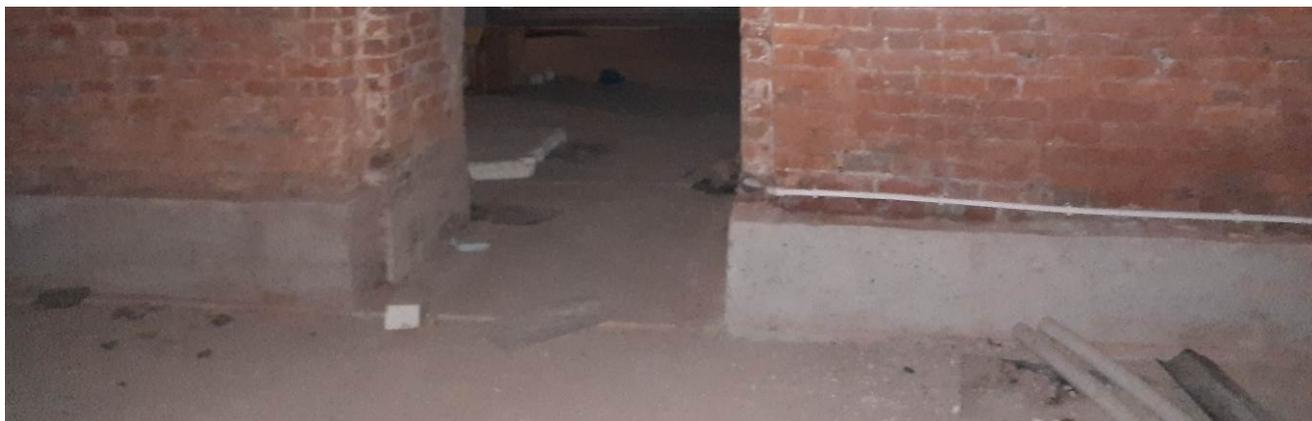
Фото 7. Усиление фундаментной стены железобетонной рубашкой
