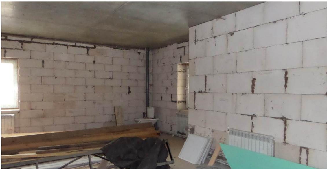
Фото 8. Наружные стены из пеноблоков
