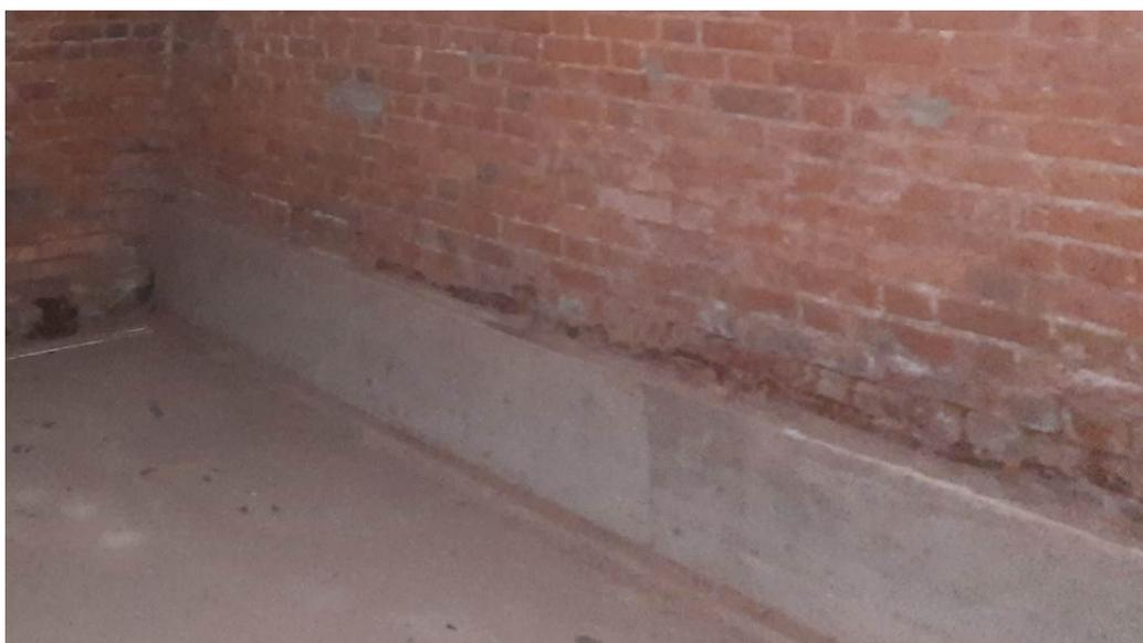
Фото 6. Усиление фундаментной стены железобетонной рубашкой
