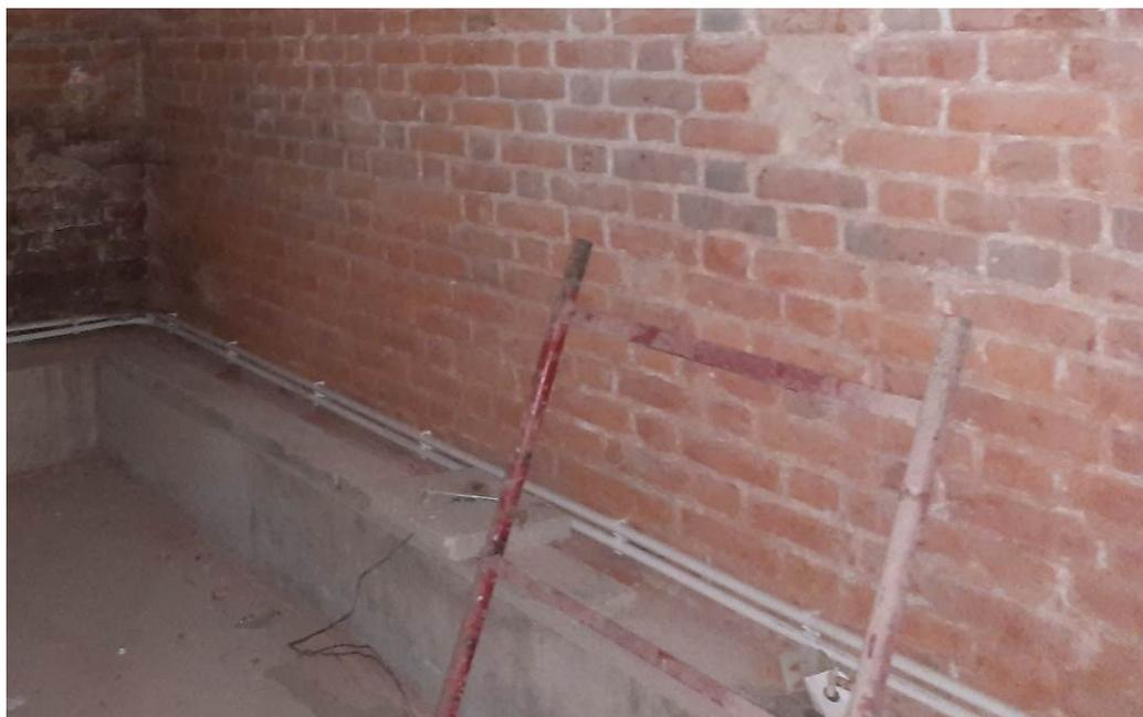
Фото 5. Усиление фундаментной стены железобетонной рубашкой
