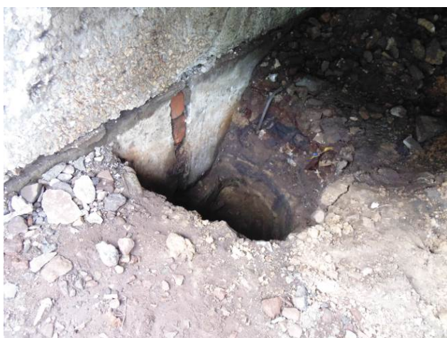
Фото 6. Фото 7. Проходка шурфа №1.
