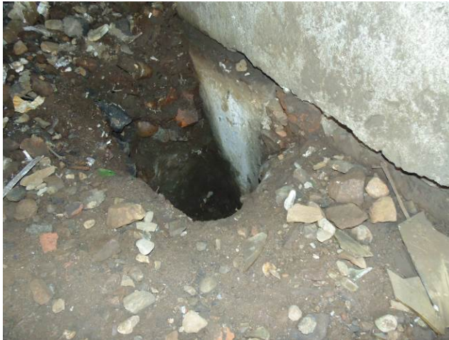
Фото 8. Фото 9. Проходки шурфов № 2 и № 3.
