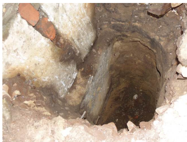
Фото 6. Фото 7. Проходка шурфа №1.
