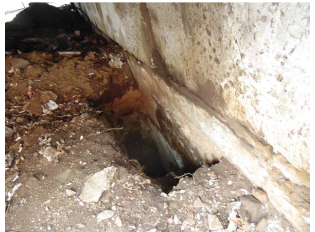
Фото 8. Фото 9. Проходки шурфов № 2 и № 3.
